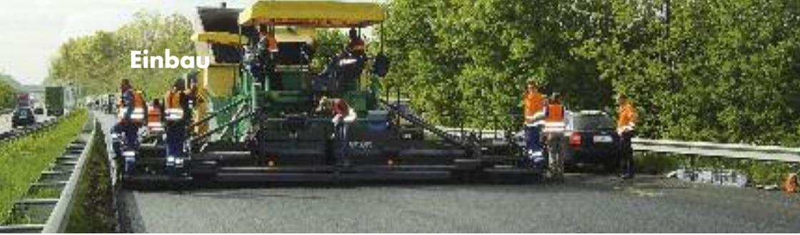
Aufgrund des kleineren Einbauzeitfensters ist bei den temperaturabgesenkten Walzasphalten eine besonders effektive Einbautechnologie erforderlich:
