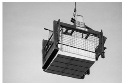
*Steintransport mit Steingreifer ohne eingehängte Auffangplane*
