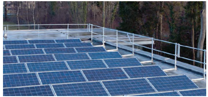
Abb. 3: Selbsttragendes Seitenschutzsystem für den Einsatz auf Flachdächern
