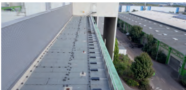
Abb. 8: Dachgeländer mit Auflast ohne Durchdringung
