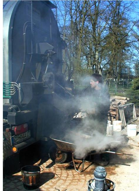
Abbildung 10: Umfüllen des Gussasphaltes vom Rührwerkskessel in einen Schubkarren
