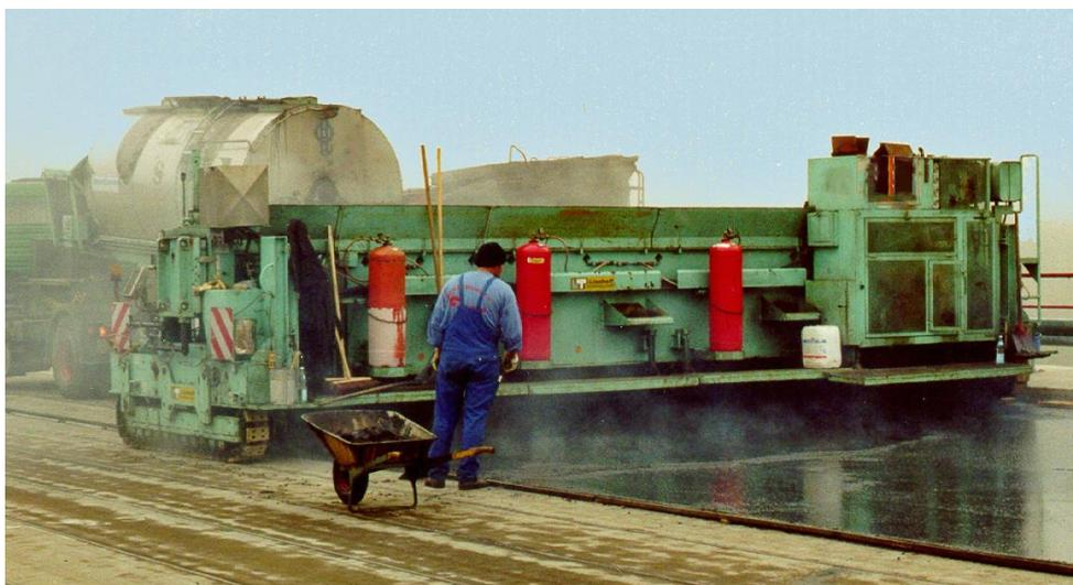
Abbildung 9: Maschineller Einbau von Gussasphalt
