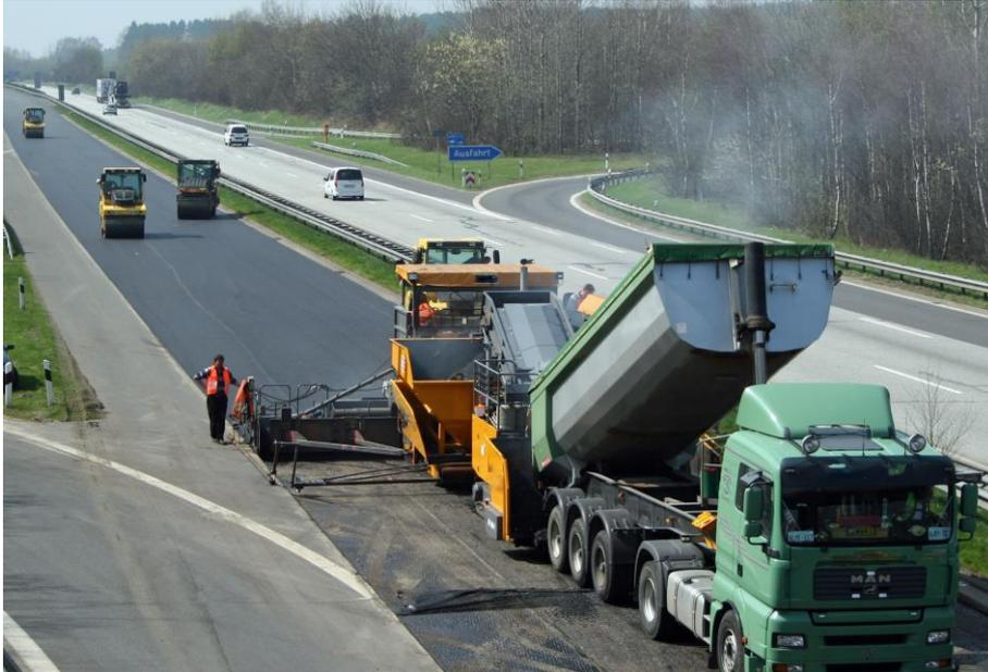
Abbildung 6: Asphaltfertiger mit Fertigerfahrer (unter dem Fertigerdach), Bohlenführer (links neben der Bohle) und Walzenfahrer
