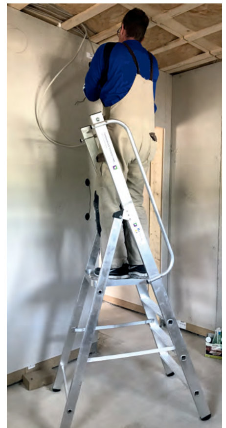
Abb. 3: Leichte Plattformleiter im Einsatz, hier 4-stufig (Quelle: J. Maringer, BG BAU)
