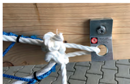
Abb. 6: Befestigungsmöglichkeit für kleinformatige Schutznetze: CLIFF Gr. 12/30 (Foto: Weglage GmbH & Co. KG)
