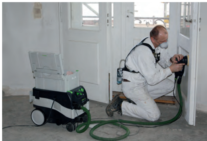
Abb. 2: Anschleifen bleihaltiger Farben
