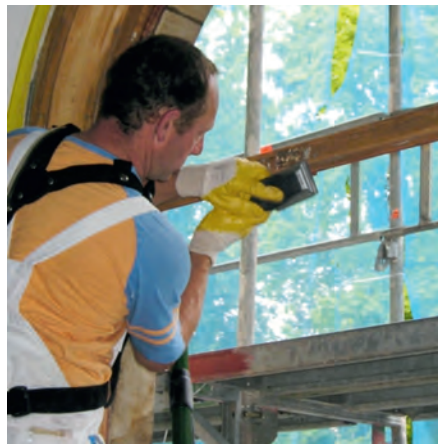
Abb. 3: Nachschleifen abgebeizter Flächen mit einem abgesaugten Schleifpad
