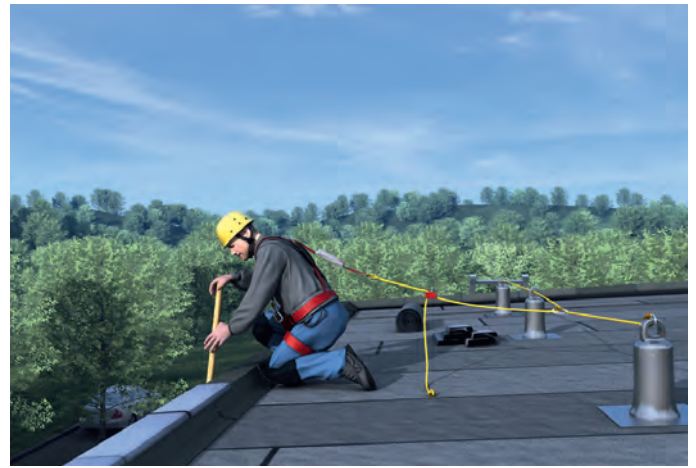
Abb. 3: Dauerhafte Anschlageinrichtungen zum Befestigen persönlicher Schutzausrüstung gegen Absturz (Quelle: BG BAU, Bausteine)
