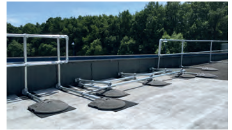
Abb. 5a und b: Mit klappbaren freistehenden Umwerrungen wird weder die Gebäudeansicht noch die Dachhaut beeinträchtigt, dafür spart man viel Zeit bei regelmäßig anstehenden Instand- haltungsarbeiten auf dem Dach (Foto: Kee Safety GmbH)
