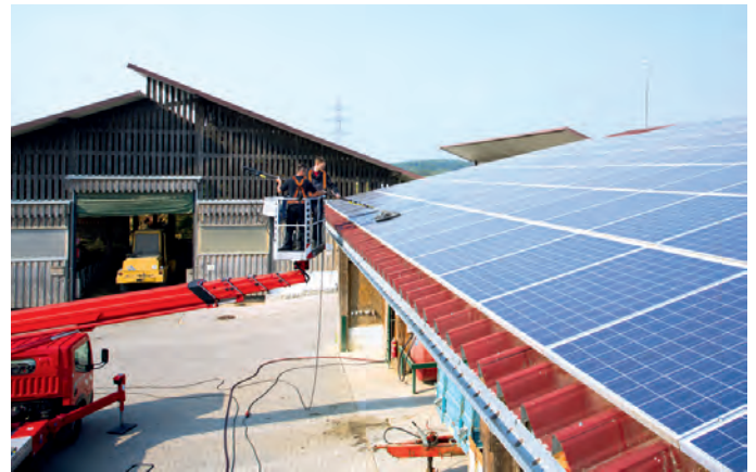
Abb. 10: Reinigung einer Solaranlage mit einem Hubsteiger (Foto: Kärcher)
