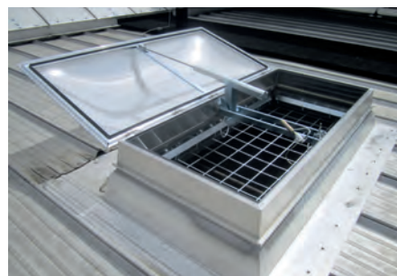
Abb. 7: Schutzgitter zur Sicherung gegen Durchsturz. Es werden auch Nachrüstsysteme angeboten (Foto: ETANCO GmbH)
