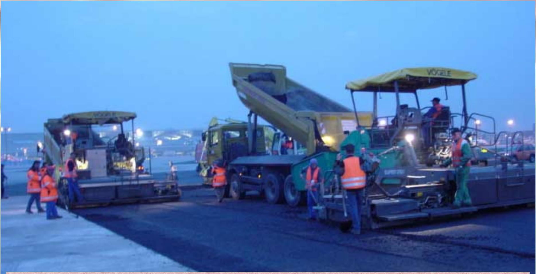
**Nur mit Niedrigtemperatur-Asphalt ist die Landebahn des Flughafen Frankfurt bei laufendem Betrieb zu sanieren**
