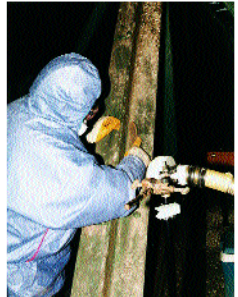
Abb. 13: Reinigungstätigkeit an einem durch Taubenkot verschmutztem Stahlträger. Die Verschmutzung wird mit Hilfe einer Drahtbürste entfernt. Der Atemtrakt des Arbeitnehmers ist weniger als eine Armlänge von der Verschmutzung entfernt. Rechts ist ein Probenahmekopf eines MD 8-Luftkeimsammlers zu sehen
