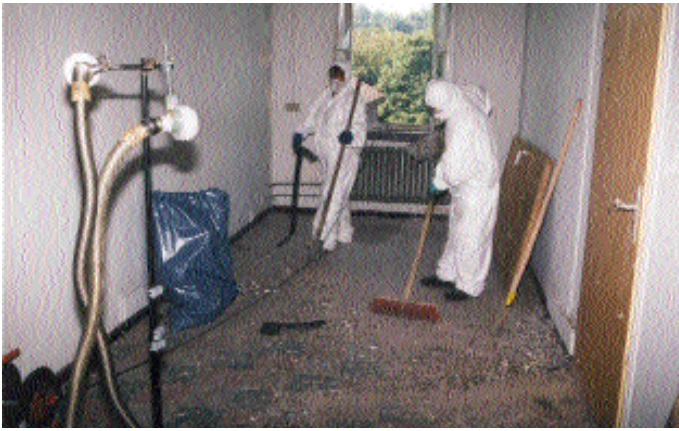
Abb. 12: Reinigungstätigkeiten im Obergeschoss eines leerstehenden Hauses in Stuttgart. Der überwiegend trockene Taubenkot wurde mit Schabern und Besen zusammengekehrt und in Kunststoffsäcke verpackt. Im Vordergrund links sind zwei Probenahmevorrichtungen von Filtrationssammlern zur Erfassung luftgetragener Mikroorganismen zu sehen.
