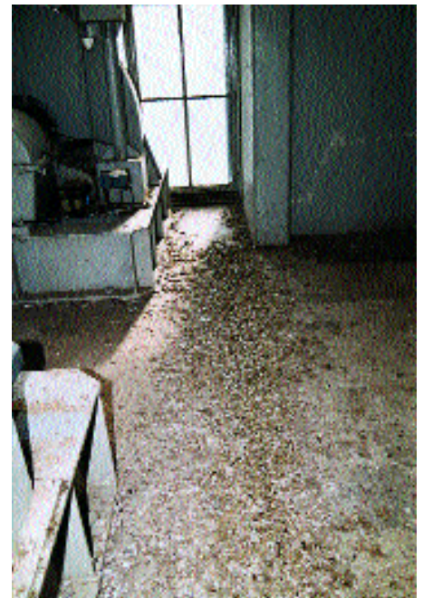
Abb. 10: Mit Taubenkot verunreinigter Maschinenraum eines Wehres in Brandenburg. Der Kot auf dem Fußboden sowie an den Maschinenteilen war überwiegend trocken. Zu Beginn der Messungen befanden sich einige Tauben im Raum
