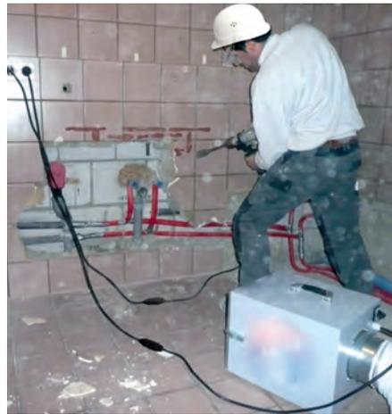
Abb. 2: Einsatz eines Luftreinigers beim Abstemmen von Fliesen (Die Verwendung eines abgesaugten Meißelhammers ist hier erforderlich)
