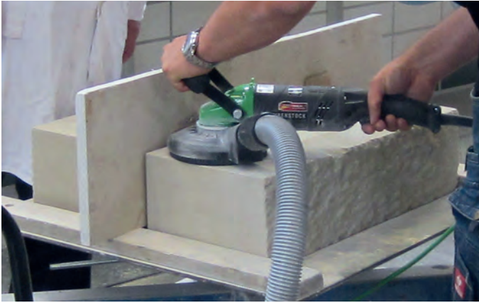
Abb. 5: Abgesaugte Handmaschine bei staubarmer Flächen- bearbeitung (Foto: W. Gunreben)
