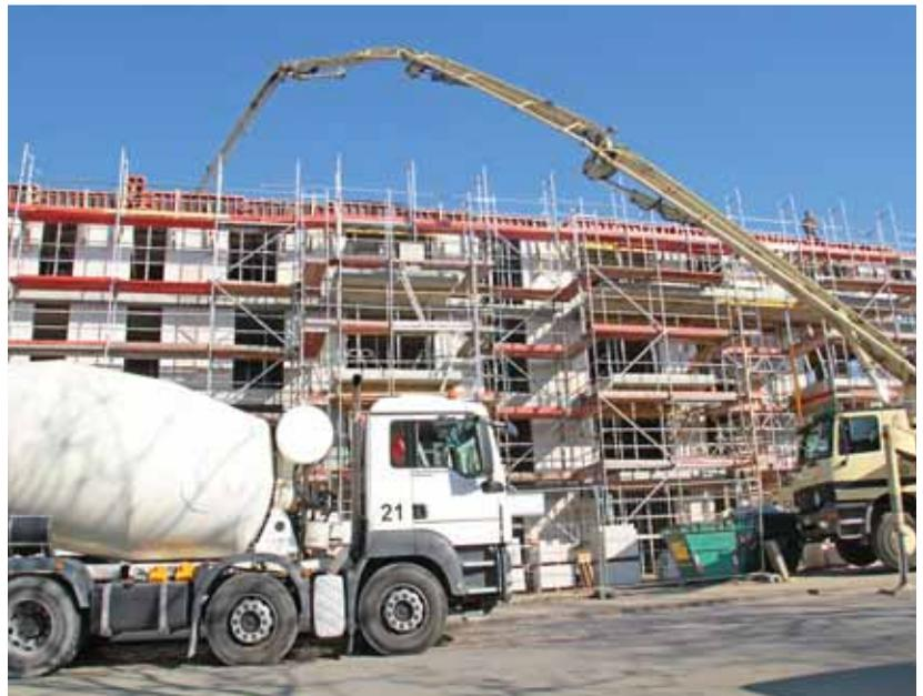
die minimale Ausfalthöhe, welche entscheidenden Einfluss auf mögliche Standorte und somit auf die Maschinenauswahl haben. Der Platzbedarf allein für die notwendige Abstützbreite kann auf 10,5 Meter anwachsen und es können Stützkräfte bis 300 Kilonewton (kN) auftreten.
