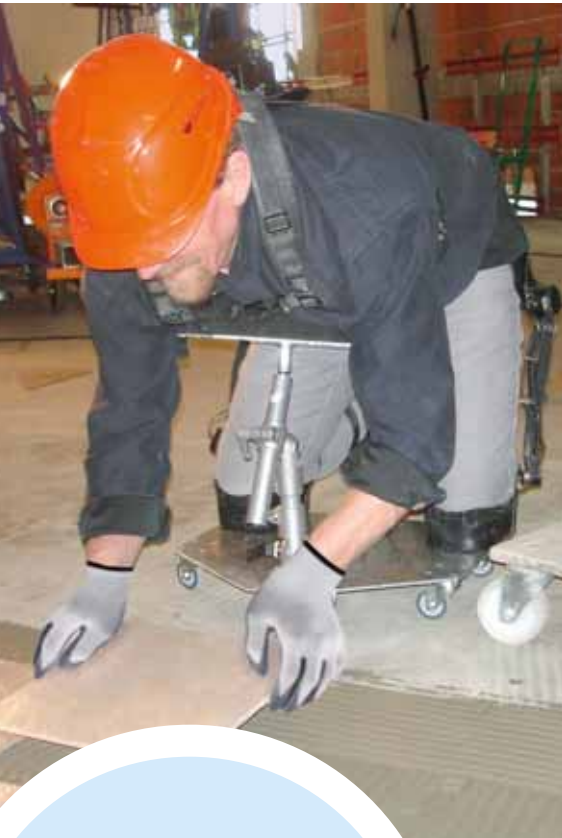
Oben: Der KNIWI-Bodenroller entlastet Knie und Rücken durch gezielte Abstützung des vorgebeugten Oberkörpers. Unten: Beim Einsatz von Teleskopstielen ist die Einstellung der richtigen Länge wichtig.
