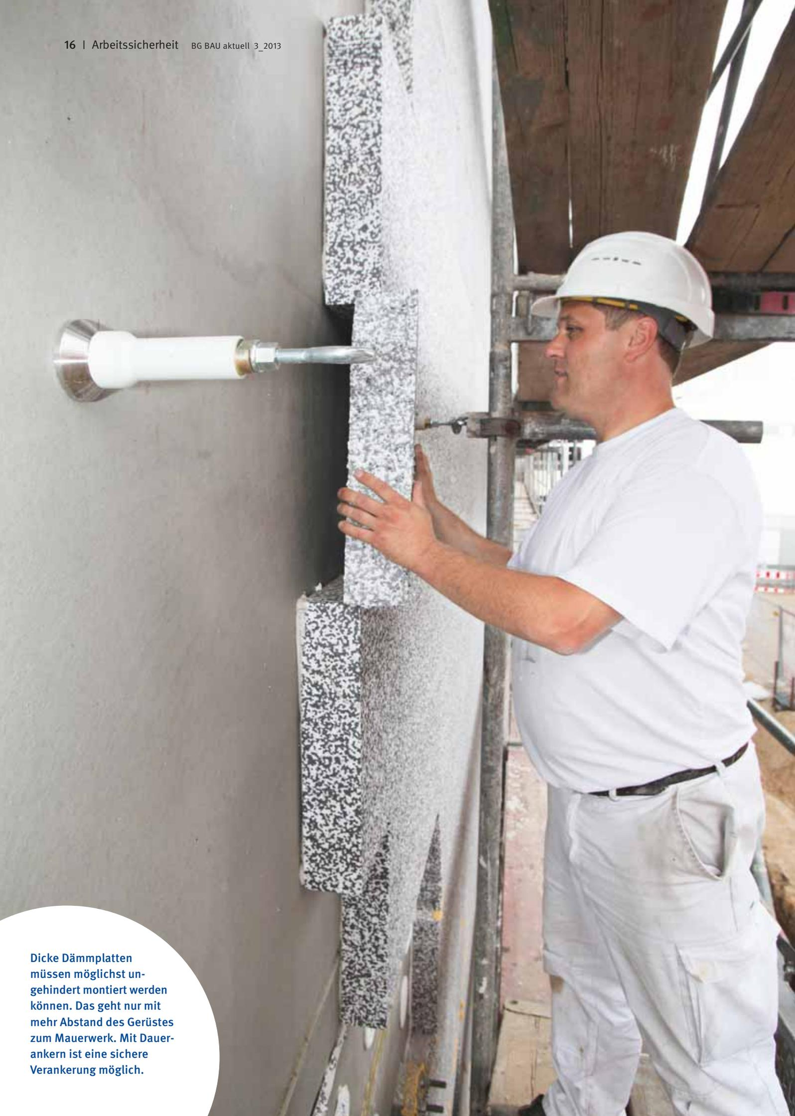
Dicke Dämmplatten müssen möglichst ungehindert montiert werden können. Das geht nur mit mehr Abstand des Gerüsts zum Mauerwerk. Mit Dauerankern ist eine sichere Verankerung möglich.
