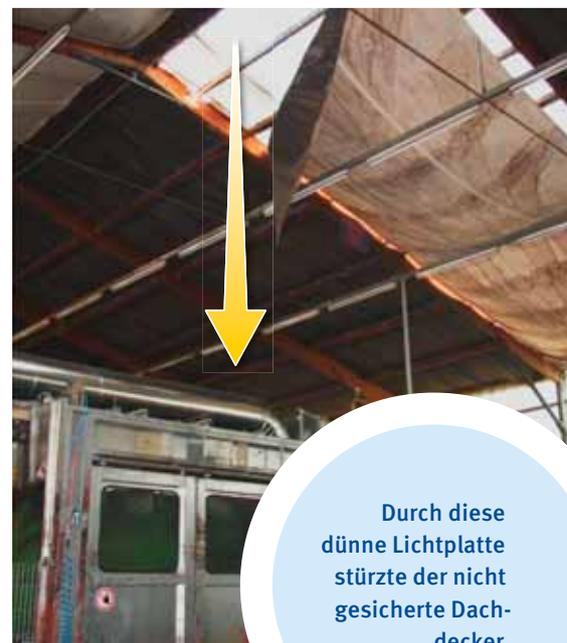
Durch diese dünne Lichtplatte stürzte der nicht gesicherte Dachdecker.
