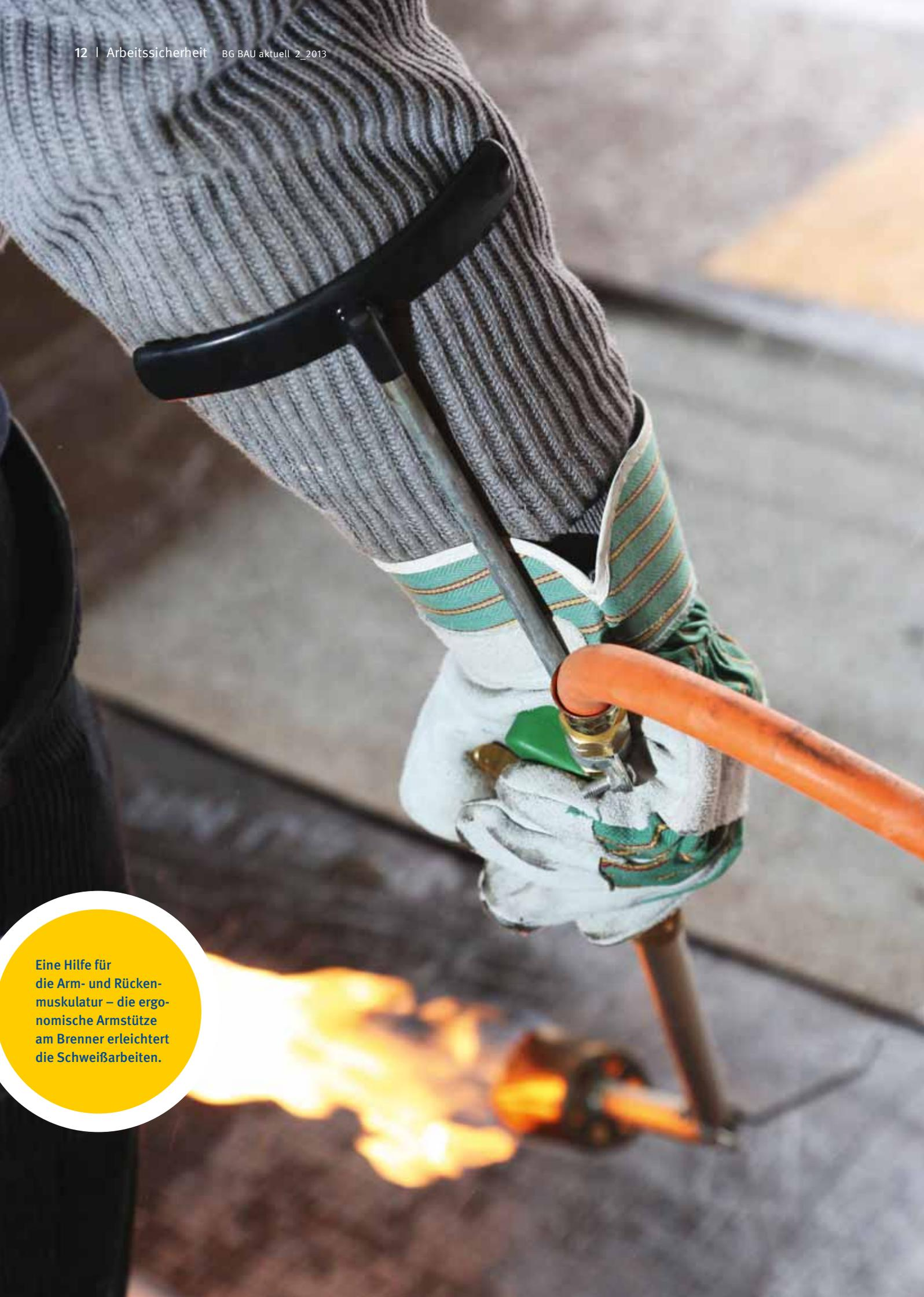
Eine Hilfe für die Arm- und Rückenmuskulatur – die ergonomische Armstütze am Brenner erleichtert die Schweißarbeiten.
