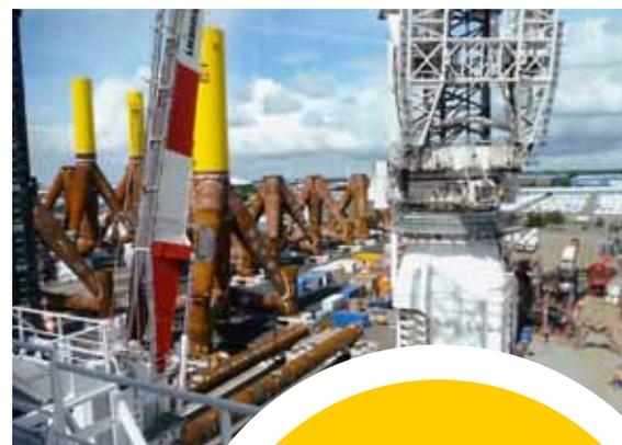
Blick von der Brücke der „INNOVATION“ im Hafen. Rechts der Schiffs-kran, links an Land die Tripoden, die auf dem Meeresgrund verankert werden und das Fundament der Windkraft-räder bilden.
