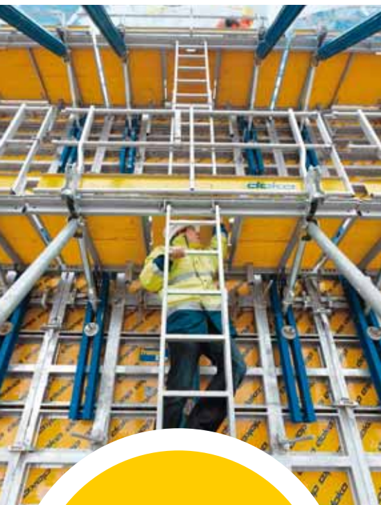
WANDSCHALUNG MIT VORMONTIERTEM SEITENSCHUTZ AUF DER GEGENSCHALUNG (SYSTEM DOKA)
