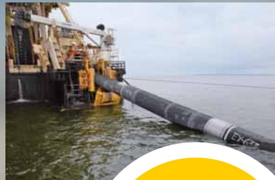
Während sich das Verlegeschiff langsam vorwärtsbewegt, wird die fertiggestellte Pipeline über einen Ausleger am Heck auf den Meeresboden abgesenkt.
