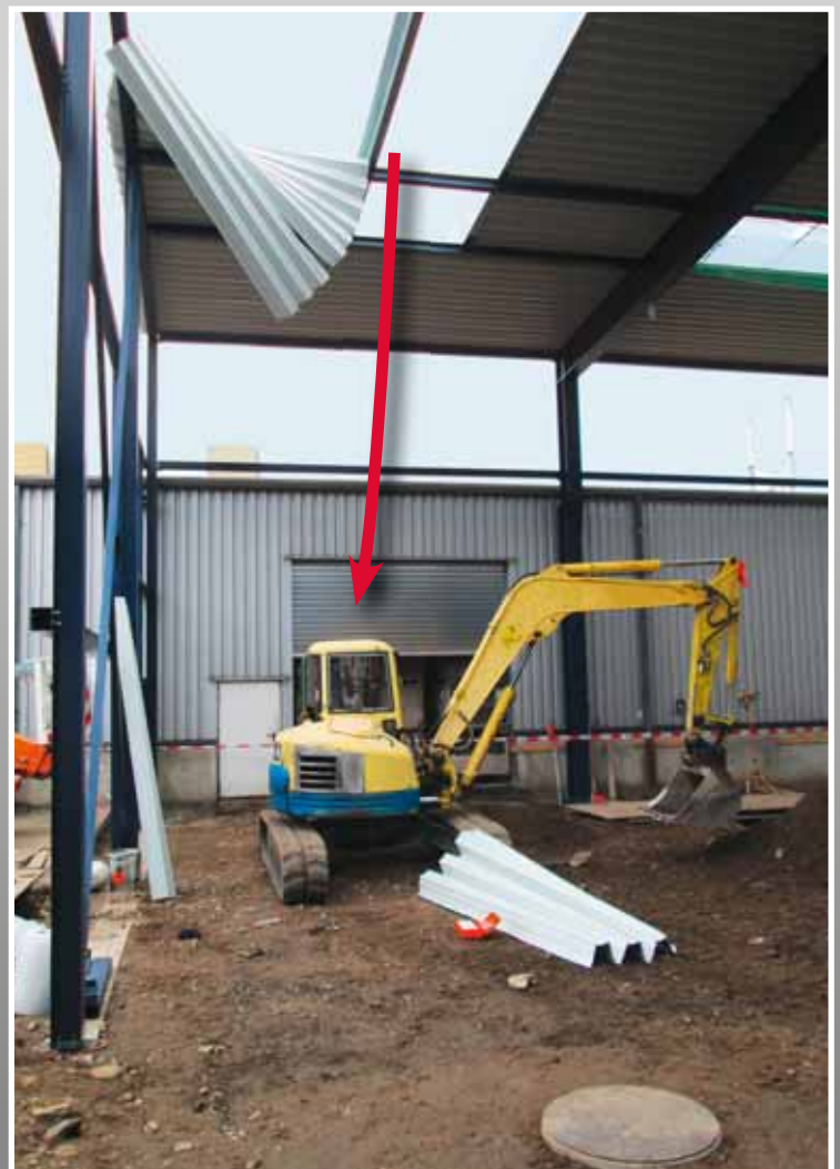
Bei Dacharbeiten stürzte ein Vorarbeiter 10 m in die Tiefe.
