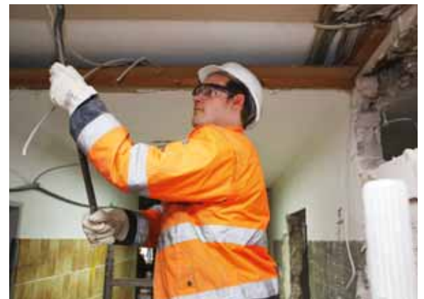
Top ↗ Schutzhelm tragen bei Gefahr herabfallender Gegenstände
