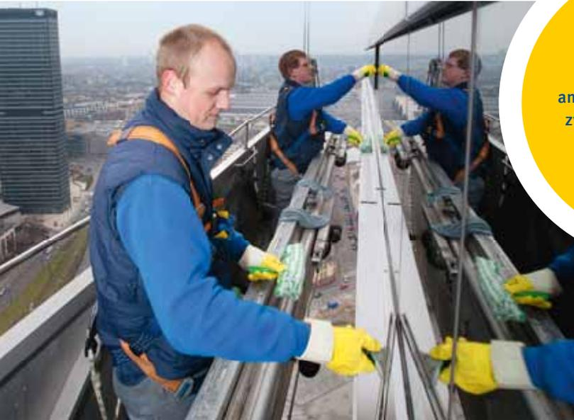
Bei Reinigungsarbeiten von Befahranlagen aus müssen immer zwei Beschäftigte auf der Bühne tätig sein.
