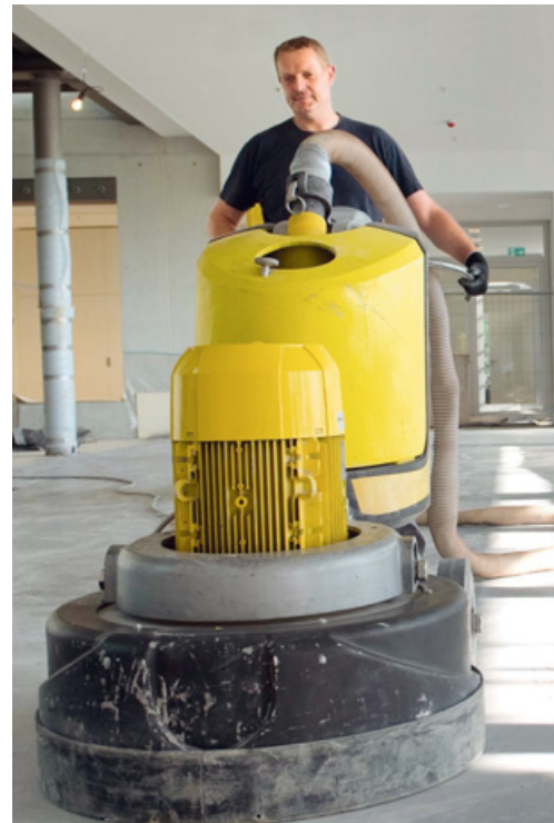
Arbeiten mit einer 3-Scheiben-Bodenschleifmaschine
