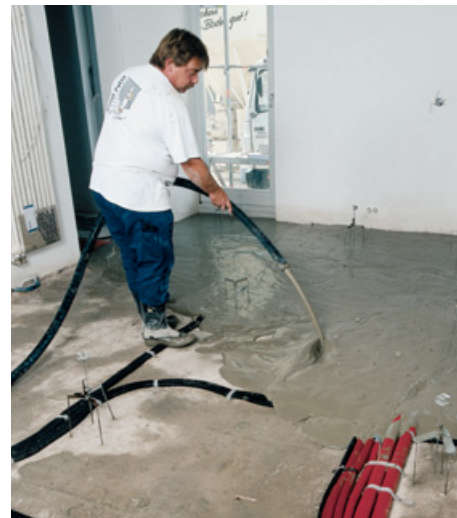
Einbauen von Ausgleichsmörtel
