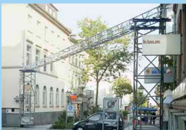
Gut geschützt: hoch gelegte Leitungen
