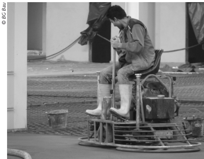
Abb. 1: Doppelflügel-Glättmaschine.
