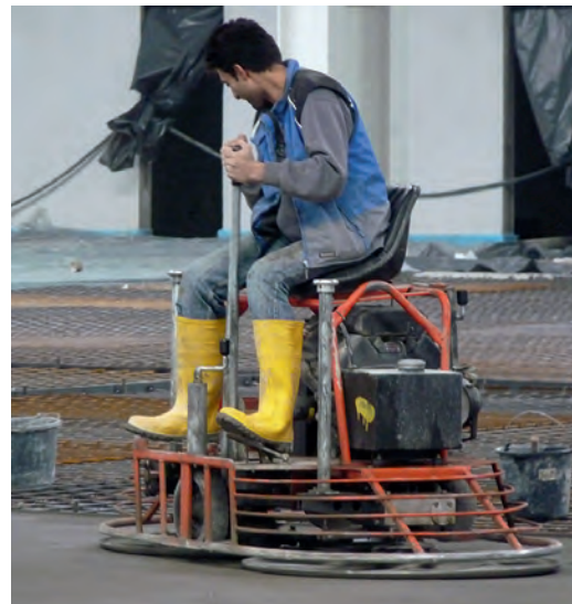
Abb. 1: Glättarbeiten in einer Halle
