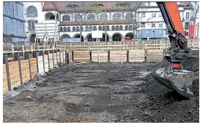
Abb. 4: Schichtenweiser Abtrag, verpflichtend bei baubegleitender Kampfmittelräumung
