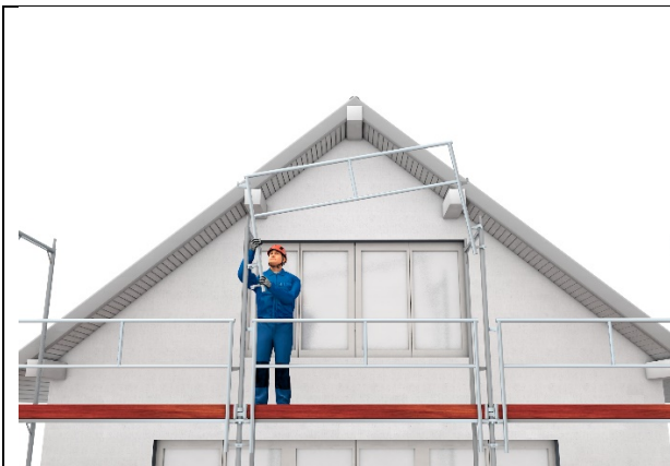
Systemimmanentes, im Gerüst verbleibendes Seitenschutzbauteil
