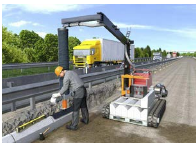
Vakuum-Versetzergerät mit Versetzzange geeignet für Bordsteine oder Kabelkanäle
