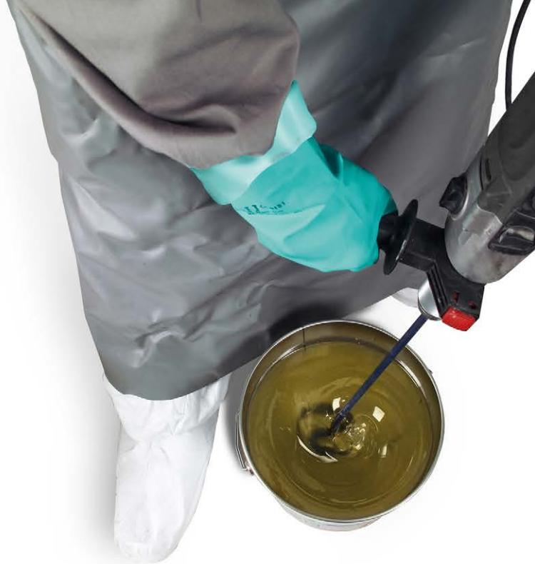
Gegen die festgestellten Gefährdungen sind wirkungsvolle Schutzmaßnahmen zu ergreifen. Die Verarbeitung muss grundsätzlich mit persönlicher Schutzausrüstung (PSA) erfolgen – weitere Maßnahmen hängen vom Gefährdungsprofil des Flüssigkunststoffprodukts und von den jeweiligen Einsatzbedingungen ab:
