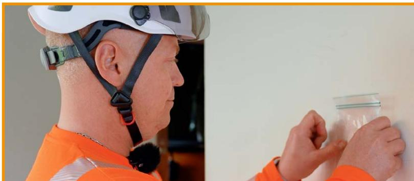
3 **Stanzschleuse anbringen:** Auf Seite der Öffnung Folie von Klebestreifen entfernen und Stanzschleuse an der Wand anbringen (Verschluss der Tüte zeigt nach oben).
