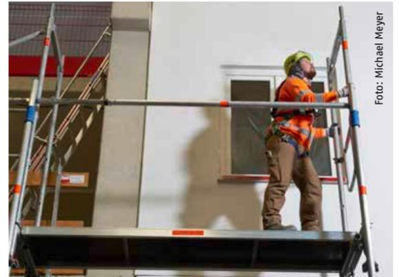
**Top** ↗ Gerüstaufbau mit vorseilendem Seitenschutz (Standard)
