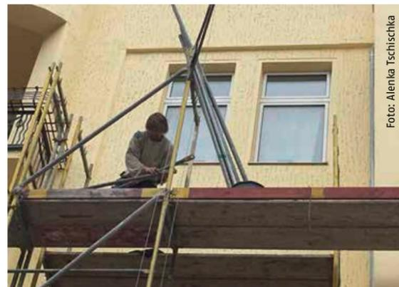
**Flop** ↘ Ungesichertes Arbeiten auf ungesichertem Gerüst
