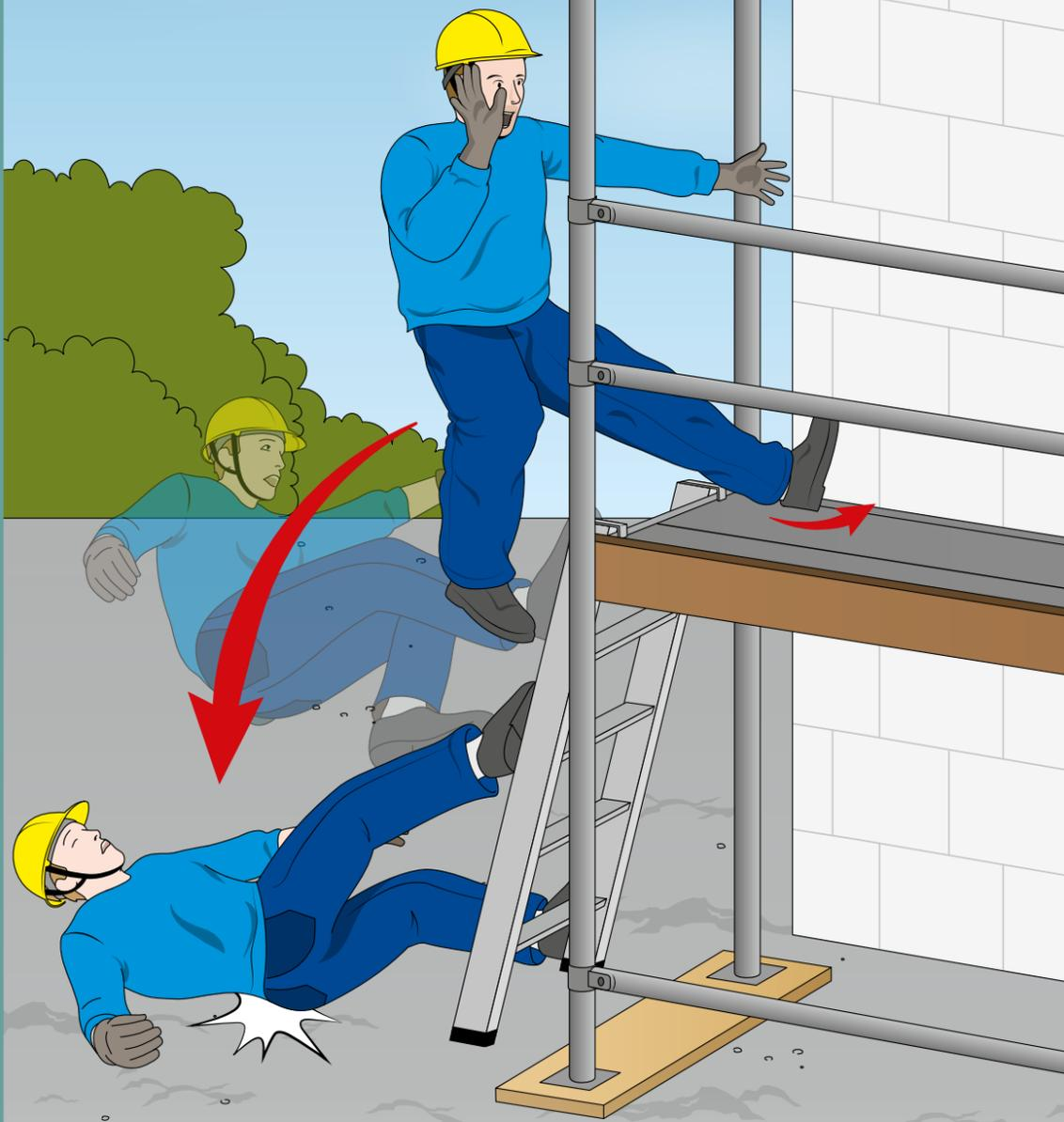
Beim Bau eines Einfamilienhauses arbeiteten an einem Tag Anfang Dezember drei Kollegen auf der Baustelle. Die Rohbauarbeiten waren abgeschlossen und das Dachgebälk erstellt. Ein Arbeits- und Schutzgerüst umgab das Einfamilienhaus und die angrenzende Garage.
