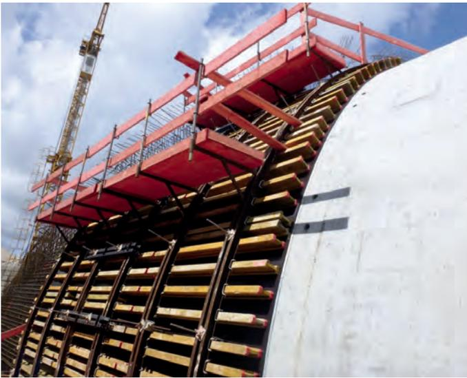
Abb. 7: Gewölbe-Konterschaltung mit eingebolzten Sonderkonsolen
