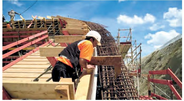
Abb. 12: Probemontage Schalung Aufkantung
