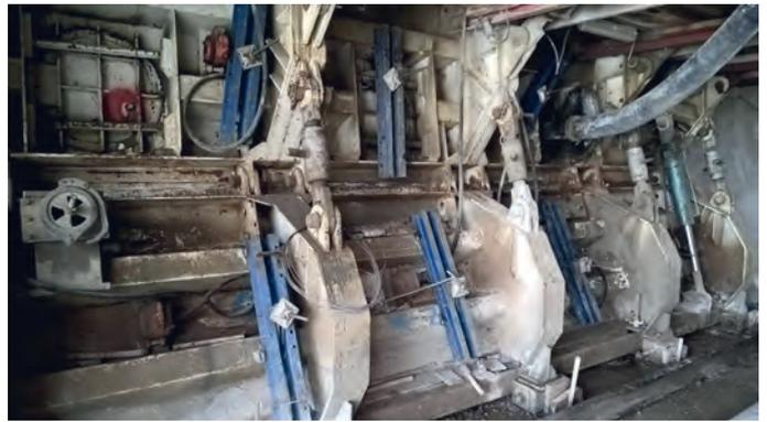
Abb. 8: Abtragung der Ankerkräfte auf die Längsspannen der Innenschalung mittels vertikaler Überwurfgurten
