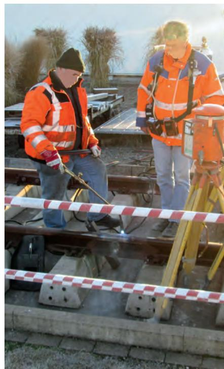
Wird Gas zur Ausarbeitung des Schienenfehlers eingesetzt, ist ebenfalls wiederum zwischen Propangas und Acetylen abzuwägen, wie oben unter „Konsequenzen für das Vorwärmen der Schienenenden vor dem Schweißen“ aufgezeigt.
