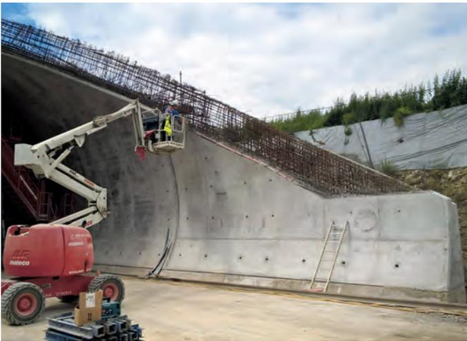
Abb. 18: Säuberungsarbeiten an der Arbeitsfuge von einer Hubarbeitsbühne aus
