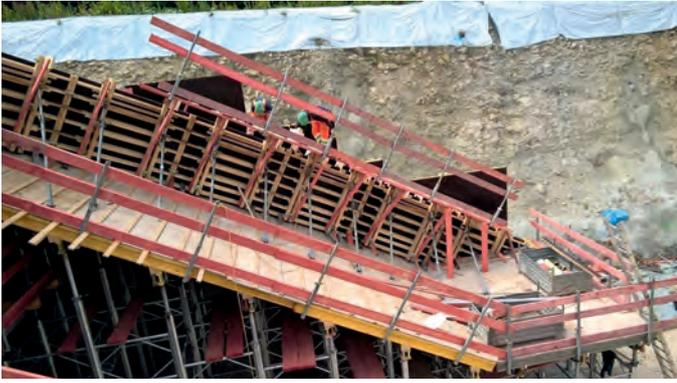
Abb. 11: Zimmermannsmäßige Betoniergerüste zum Betonieren des Kragens
