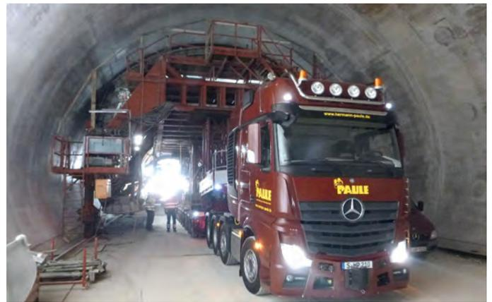
läufer-Nachläufer-Prinzip zum Einsatz. Die Schalwagen konnten gebraucht von einer ARGE der NBS Ingolstadt–Erfurt übernommen und für den Tunnel Widderstall adaptiert werden. Dazu wurde eine fahrbare, ankerlose Außenschalung konstruiert und hergestellt.
