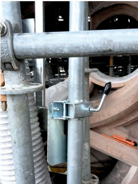
Abb. 6: Klemmhalterung für nachführbaren Absaugarm am Gerüstrohr (Foto: Fa. Möcklinghoff)
