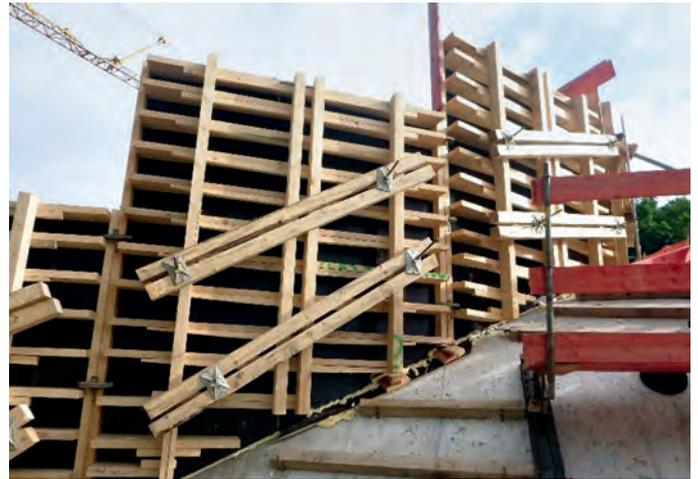
Prototyps. Zunächst wurde der untere Teil des Portalkragens bis zur Arbeitsfuge vorbetoniert (Abb. 13). Die Kragen-Außenschalung mit Überstand als Absturzicherung wurde als Schließschalung geplant. Sie wurde als Holz-Abbund-Schalung ebenso vom W&F-Schalungsbau einsatzfertig vormontiert geliefert (Abb. 14).
