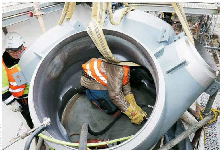
Montage eines Stahlgussknotens der Baumstützen, auf denen die Sky Line-Bahnstation an Terminal 1 ruht
