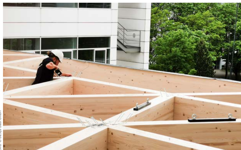
Montage der Holzelemente für die Magistrale
