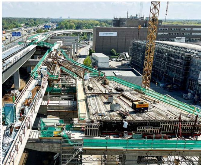
Mit Fangnetzen gesicherte Baustelle der Gleisharfe.
