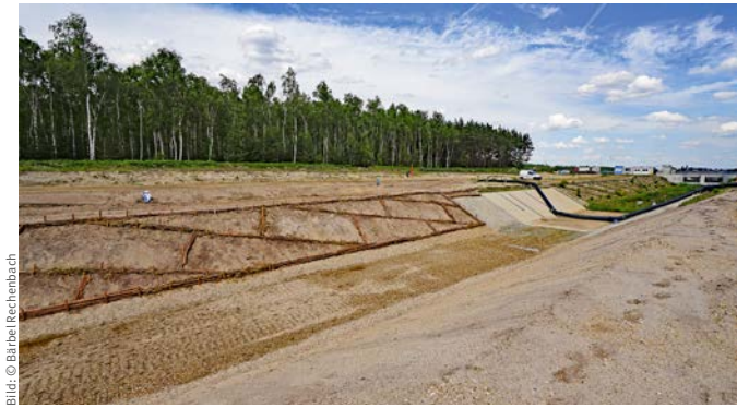
Sicherung der Böschungen mit Faschinen
