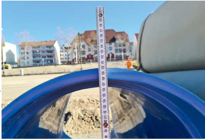
Bild: © Aarsleff Rohrsanierung
