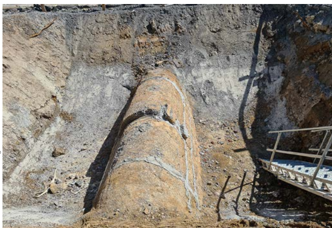
Bild: © Aarsleff Rohrsanierung
