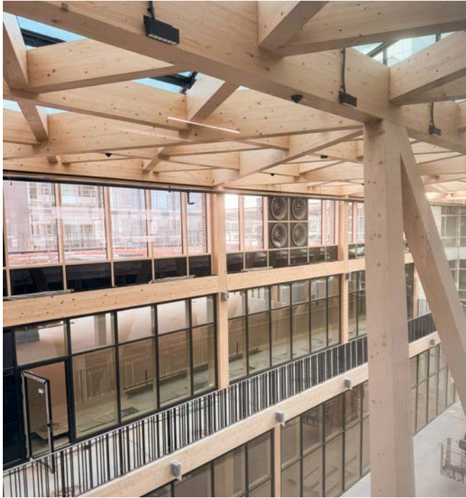
Blick aus einem Innenraum auf die Magistrale
