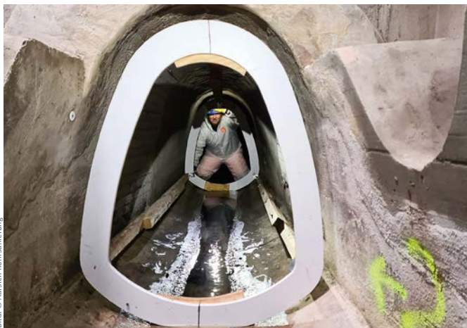
Mit der extra angefertigten Schablone des parabelförmigen Best-Fit-Querschnitts wird die Hindernisfreiheit in allen drei Dolen geprüft.
