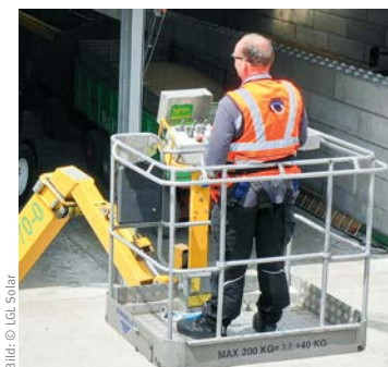
Der Reinigungskran wurde von einem Mitarbeiter, der mit PSaGA gesichert auf einer Hebebühne stand, gesteuert.
