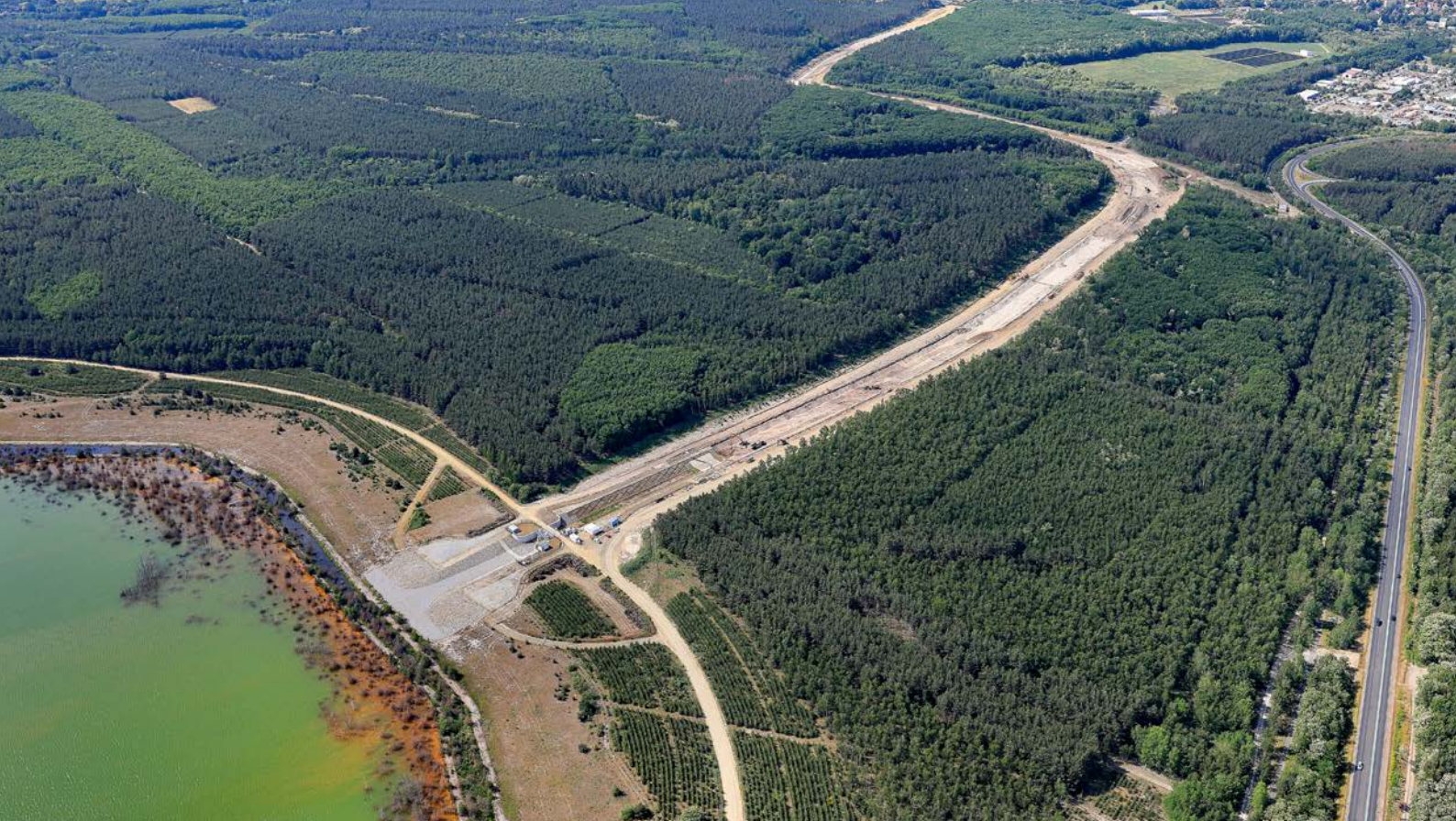
Luftbild des im Bau befindlichen Ableiters zwischen Sedlitzer See und Schwarzer Elster
