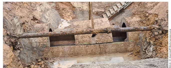
Damit die Rohre in die Dole eingebaut werden können, wird der Altkanal aufgeschnitten und die Stampfbetonhaube zunächst zwischengelagert.
