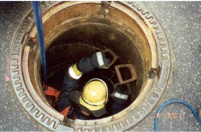
Einstieg über fest verbaute Steigeisen bei einer Rettungsübung | Verengter, nicht zulässiger Schachteinstieg mit einer Sprossenanlegeleiter
