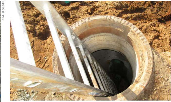
Einstieg über fest verbaute Steigeisen bei einer Rettungsübung | Verengter, nicht zulässiger Schachteinstieg mit einer Sprossenanlegeleiter
