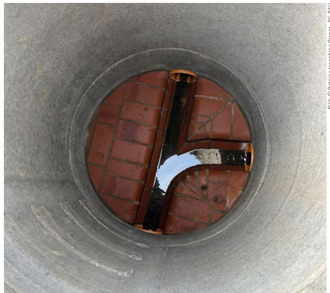
Abwasserschacht ohne fest verbaute Steigeisen
