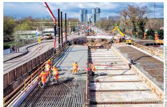
Herstellung der neuen Wegstrecken
