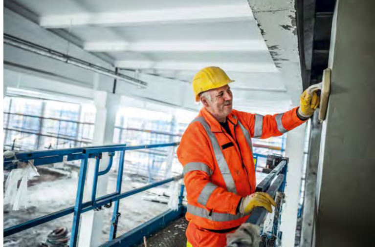
Zur Finalisierung der Oberflächen wurde der Auftrag per Hand verrieben.
