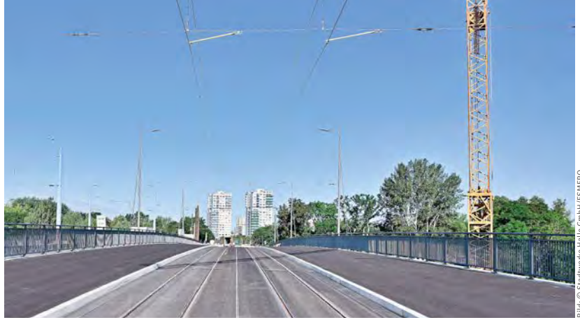
Bild: © Stadwerke Halle GmbH/ESMERO
