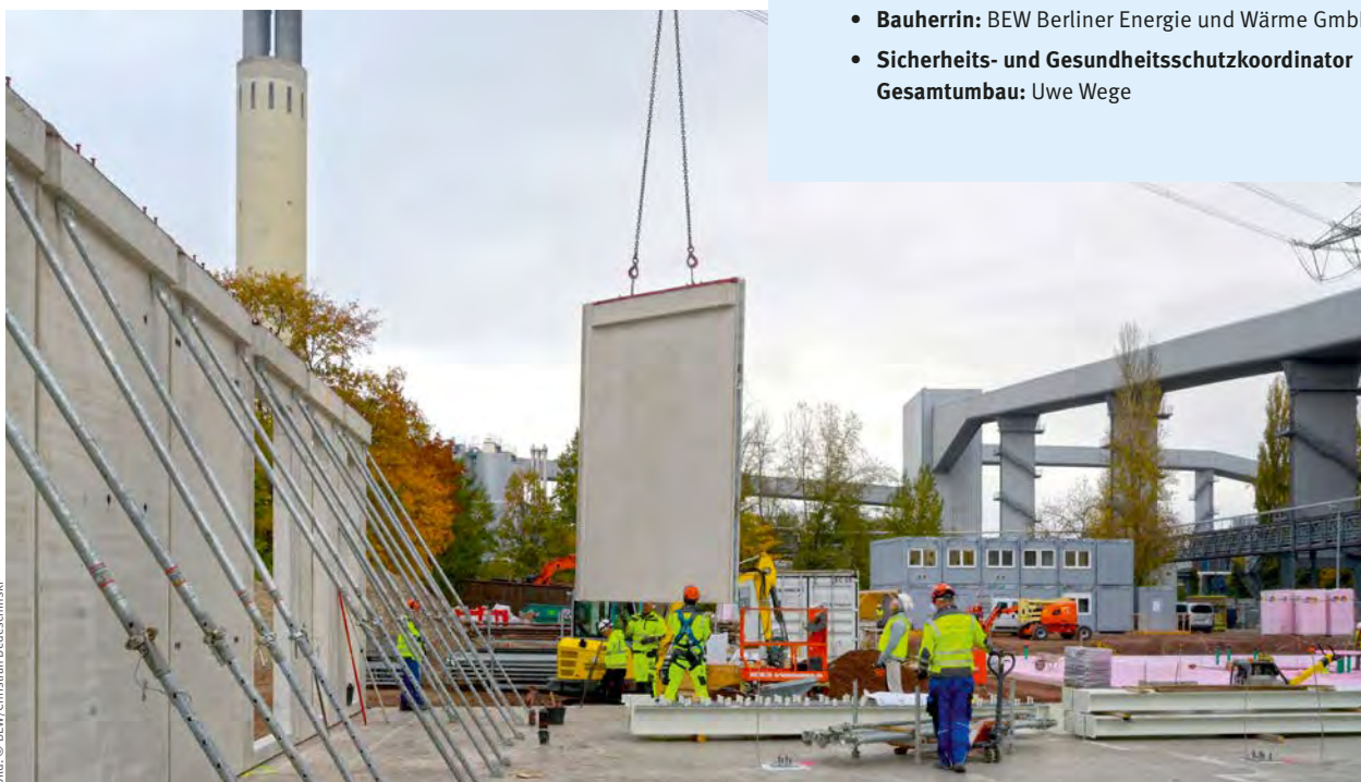
Die Neubauten des Campus Reuter entstehen aus Fertigteilen.
