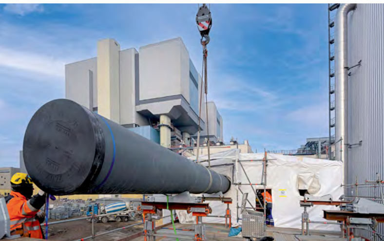
Die neue Rohrtrasse für den bestehenden Wärmespeicher erfordert millimetergenaues Arbeiten.
