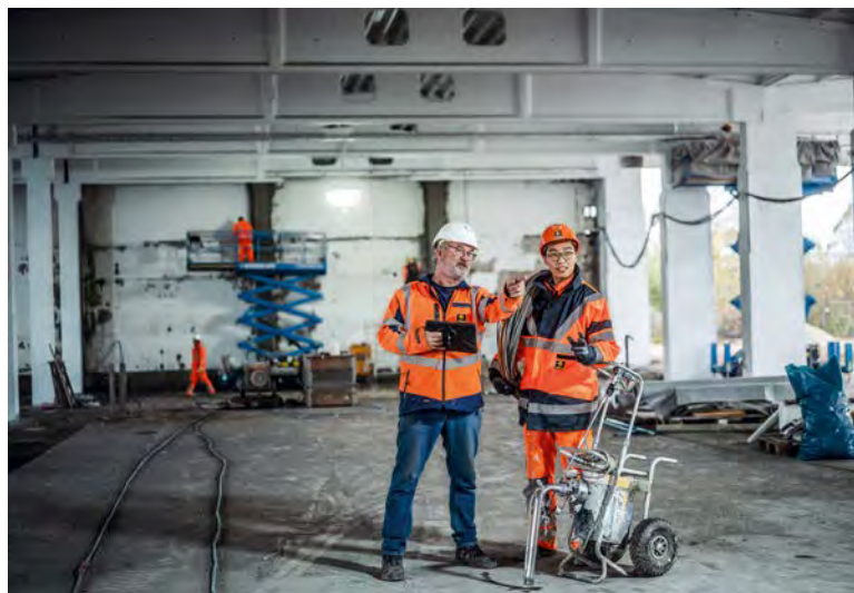
Insgesamt wurden über 90 Stützpfeiler umfangreich saniert.
