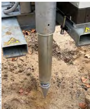
Bohrlochstopfmaschine mit Verdrängerspritze
