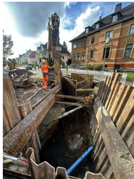
Bei Kanalbauarbeiten muss man nicht nur auf sichere Baugruben und Gräben, sondern oft auch auf den angrenzenden Verkehr und querende Leitungen achten.
