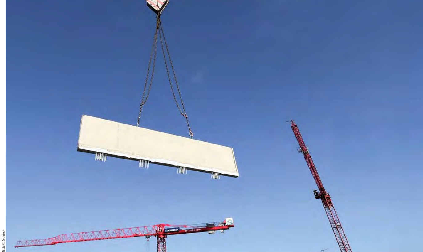
Die Dämmelemente sind bereits werkseitig in die Stahlbetonbrüstungen eingebaut.
