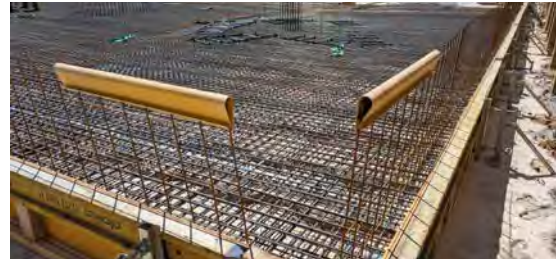
Schutzprofile am Schalungsrand
