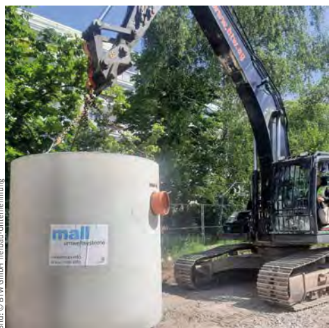
Die Filterschächte aus Stahlbeton-Fertigteilen in monolithischer Rundbauweise sind einfach zu montieren.
