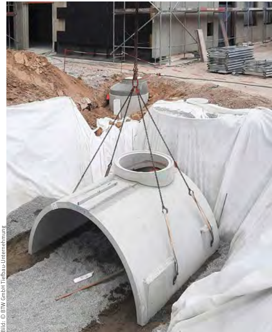
Montage der Sickertunnel in Modulbauweise
