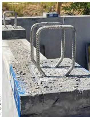
Das tragende Wärmedämmelement Scconnex dient der Wärmedämmung und Statik zugleich.
