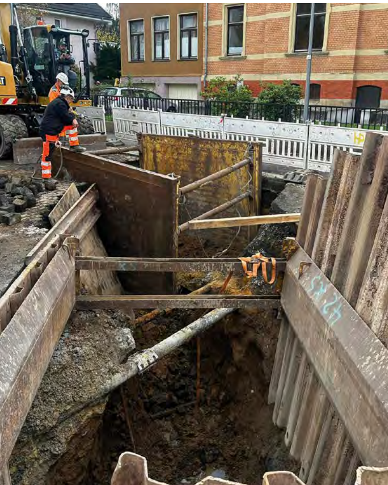
Bei Kanalbauarbeiten muss man nicht nur auf sichere Baugruben und Gräben, sondern oft auch auf den angrenzenden Verkehr und querende Leitungen achten.
