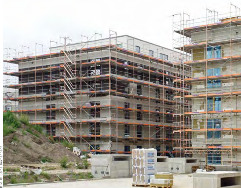
Geschossweise verschraubte und vergossene Elemente beschleunigen den Bauablauf.
