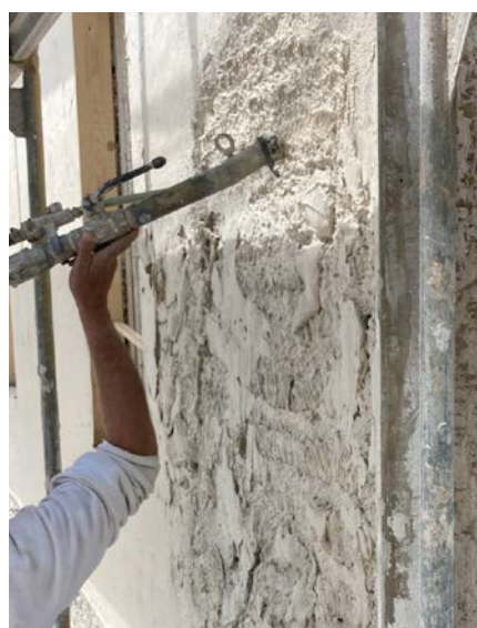
Auch wenn es (wie hier) keinen direkten Kontakt mit dem Material gibt, sollten beim Auftragen der Spritzdämmung Handschuhe getragen werden, um mögliche Hautreizungen zu vermeiden.
