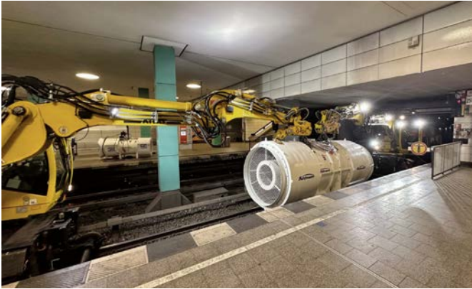
Lüfterpositionierung mit Zweiwegebagger beim Aufbau
