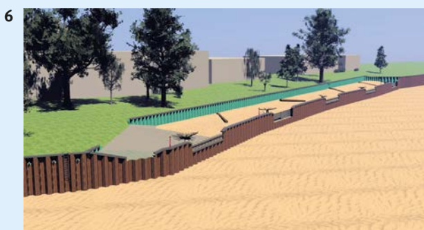
6 Nach Kies- und Sandeinbau Abschneiden der Bestandsspundwand für den Tierausstieg und Totholzeinbau
