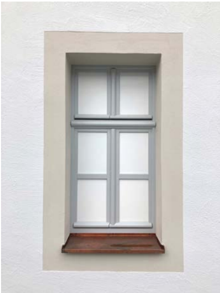
Ecken, Türen und Fenster erhielten im Zuge der Sanierung eine Verkleidung aus Holzlatten, die später nachverputzt wurde.
