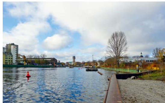
Insgesamt 16.700 m 2 Stahlpundwand wurden für die Fahrinnenanpassung verbaut.
