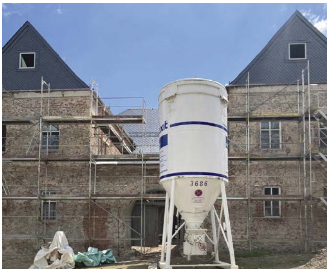
Auf die Außenwände wurde die mineralische Spritzdämmung direkt aus dem Mörtelsilo aufgebracht, im Anschluss wurde Solarfarbe, eine lösungsmittel-freie Fassadenfarbe, aufgetragen.
