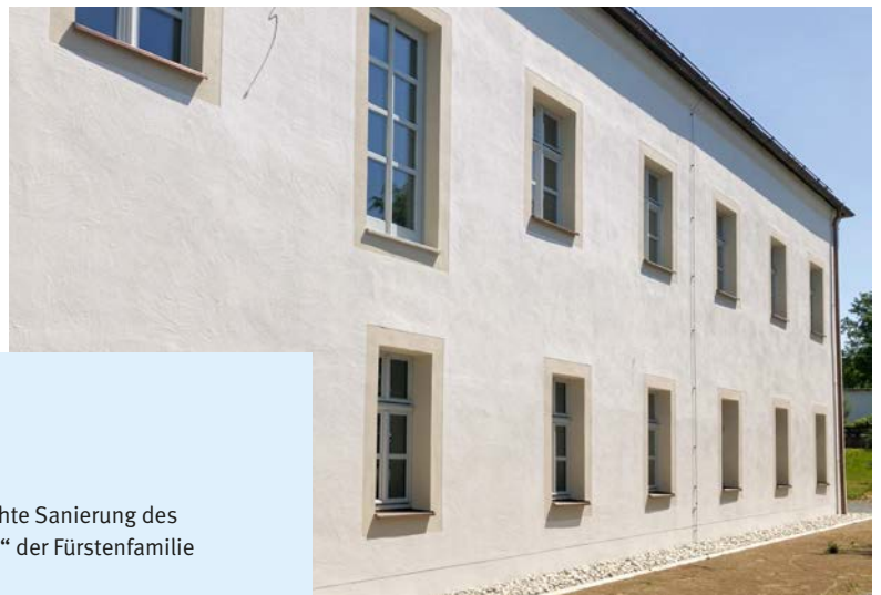
Der Fassadenputz wurde bewusst nicht völlig glattgezogen, sondern leicht uneben gestaltet, um den historischen Charme des Gebäudes zu erhalten.
