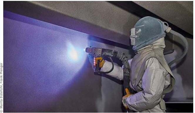
Die Spritzverzinkung erfolgt von Hand unter Vollschutz.
