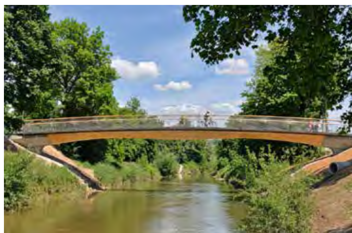
Stuttgarter Holzbrücke in Weinstadt
