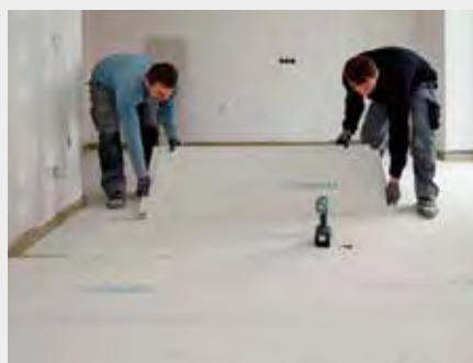
Abb. 10 · Die Verlegung der Estrich-Elemente erfolgte schwimmend im schleppenden Verband.
