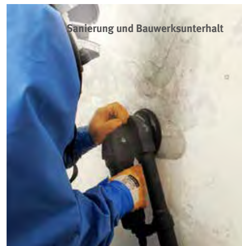
Abb. 2 · Abräsen asbesthaltiger Spachtelmasse von Beton mit abgesaugtem System und messtechnischer Begleitung
