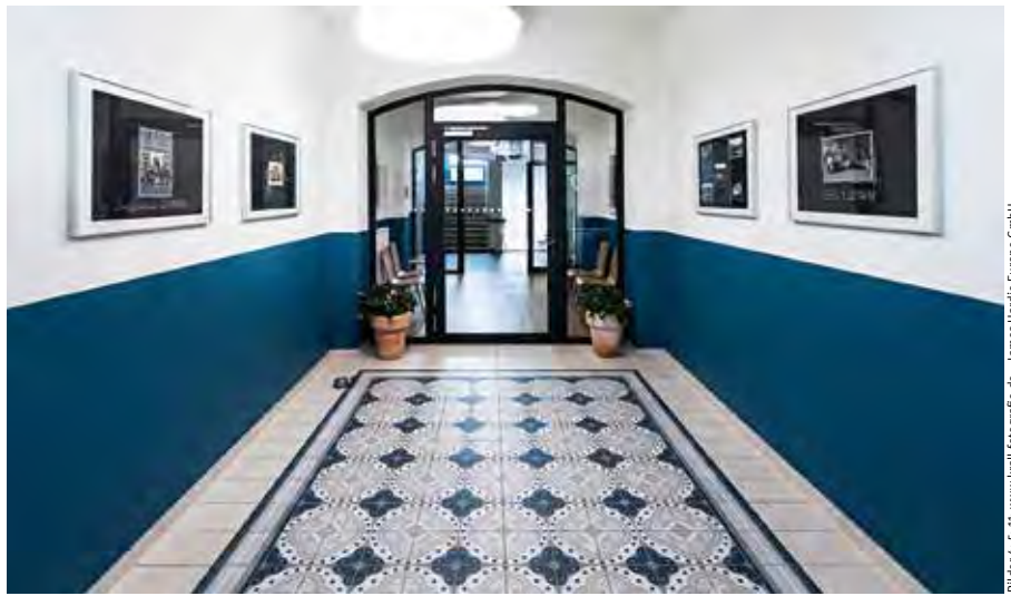
Abb. 5 · Für den Bodenaufbau im Eingangsbereich wurde auf einer neuen Stahlbetondecke Ausgleichsschüttung aufgebracht und planeben abgezogen. Das Estrich-Element wurde dann direkt darauf verlegt, verklebt sowie vollflächig verspachtelt. Abschließend wurde der Bodenaufbau mit einem PVC-Oberbelag ausgestattet.
