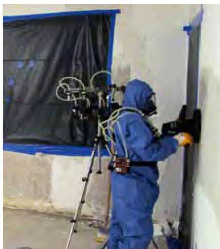
Abb. 1 · Abschleifen asbesthaltiger Spachtelmasse von Beton mit abgesaugtem System und messtechnischer Begleitung
