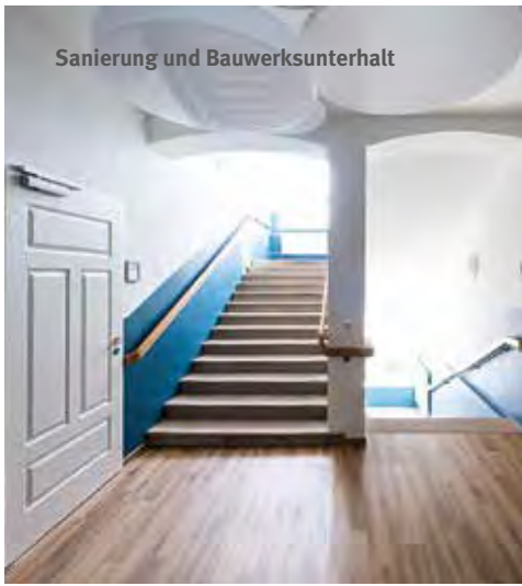
Abb. 4 · Der PVC-Bodenbelag im Flur wurde auf dem Estrich-Element 2 E 33 aufgebracht.
