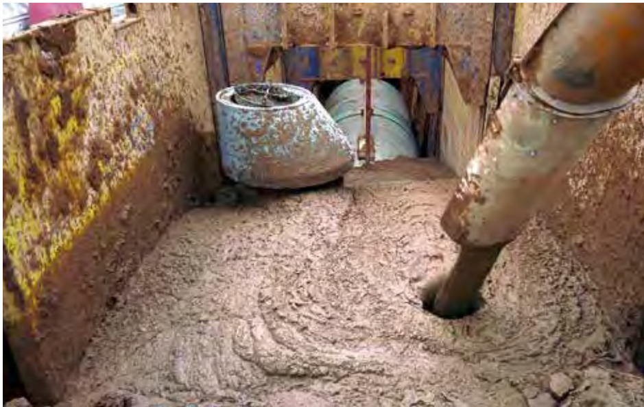
Abb. oben · Die GFK-Rohre sind gegen den Auftrieb mittels einer speziellen Technik gesichert.
