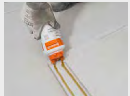
Abb. 8 · Die einzelnen Elemente wurden mit Estrichkleber verklebt. Da die Kleberflaschen mit einer Doppelöffnung ausgestattet sind, konnte die Masse in einem Arbeitsgang gleichmäßig und ausreichend dosiert in zwei Kleberschnüren aufgetragen werden.
