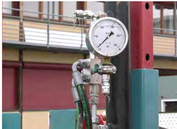
Ein Manometer misst alle relevanten Daten des Auftriebs und der Rückverfestigung exakt.
