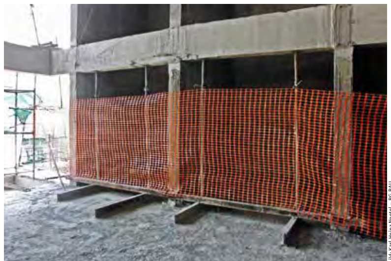
Gut gesicherte Aufzugsöffnungen
