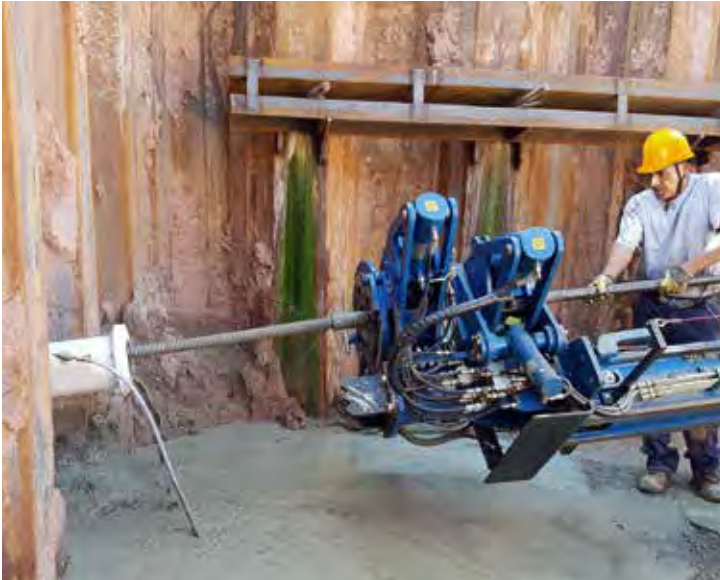
Abb. 3 · Verlängerung des Bohrgestänges
