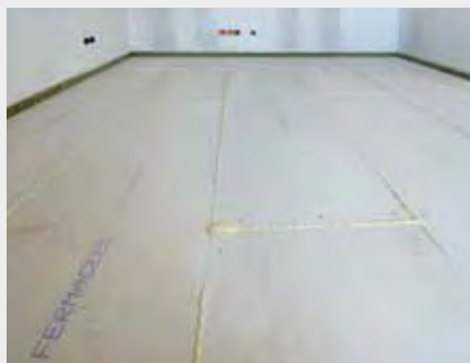
Abb. 6 und Abb. 7 · Die Trocken-Estrich-Platten können nach dem Verlegen sofort wieder betreten werden.
