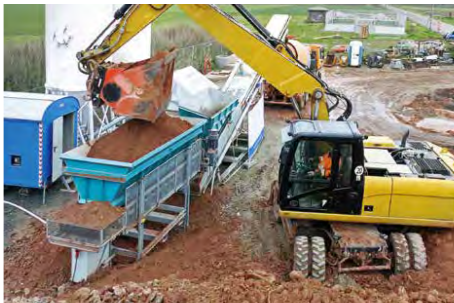
In der Aufbereitungsanlage wird der Aushub für den Flüssigboden vorbereitet.
