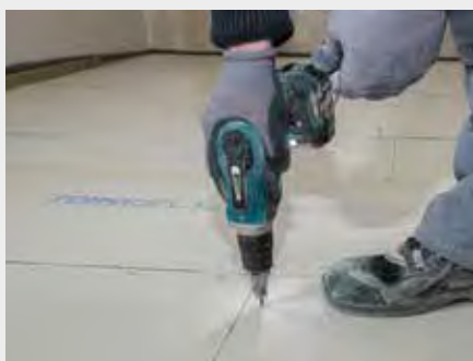
Abb. 9 · Die frisch verklebten Estrich-Elemente wurden anschließend im Falzbereich verschraubt bzw. verklammert.
