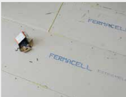
Abb. 6 und Abb. 7 · Die Trocken-Estrich-Platten können nach dem Verlegen sofort wieder betreten werden.
