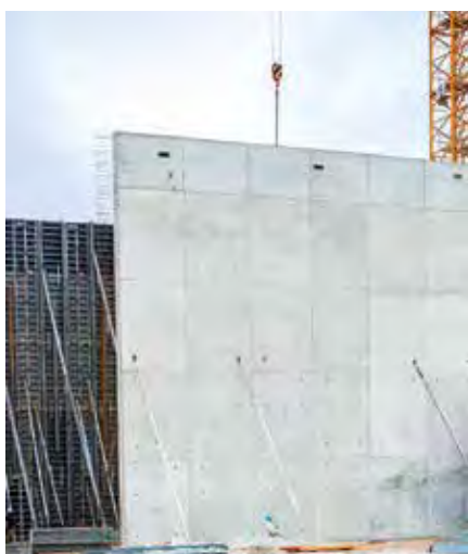
An einigen Stellen waren die zu betonierenden Wände 15,3 m hoch.
