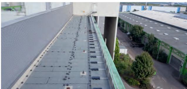
Abb. 9: Seitenschutzsysteme und Geländer zur Sicherung von Personen in absturzgefährdeten Bereichen nach DIN EN 13374
