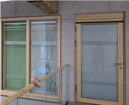
Abb. 5a, b: 7N-Tür mit verdecktem Obentürschließer und elektrischem Antrieb zur Selbstöffnung
