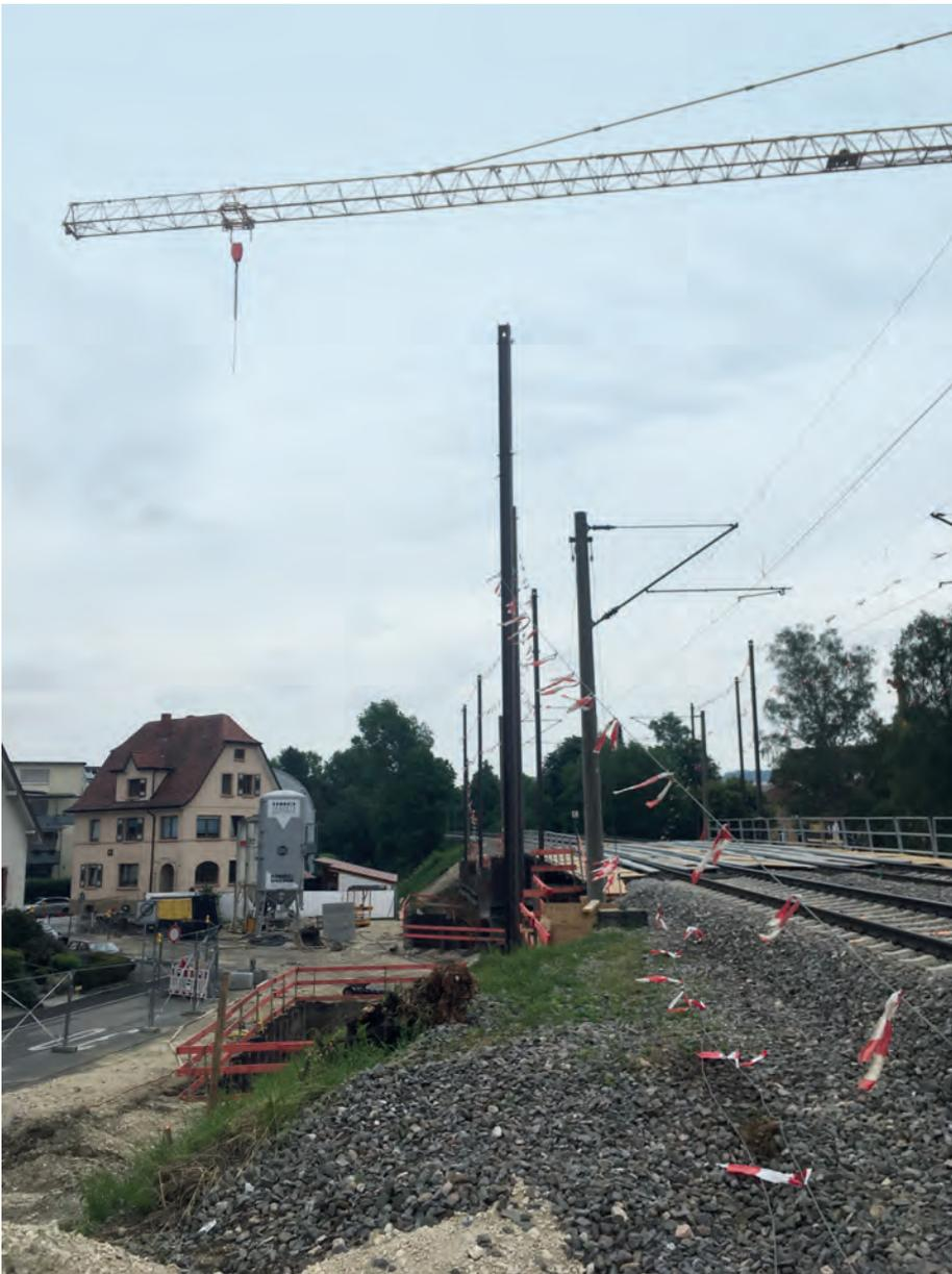
Abb. 2: Kran überschwenkt Bahn, Markierungen als Hilfe für Kranführer, jedoch keine Sicherheitsmaßnahmen
