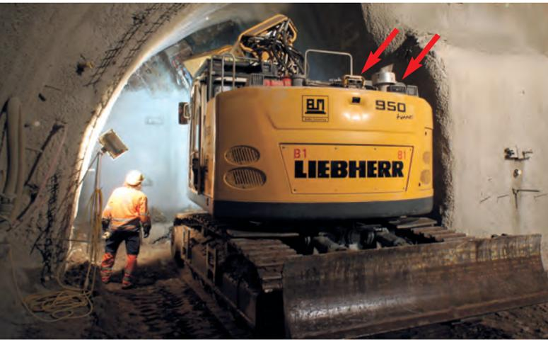
Abb. 2: Ausbruchsarbeiten im Ulmenstollen – Tunnelbagger mit aufgebauten Blaxtair-Sensoren (Anm. d. Redaktion: Bild dient der Demonstration des Systems)
