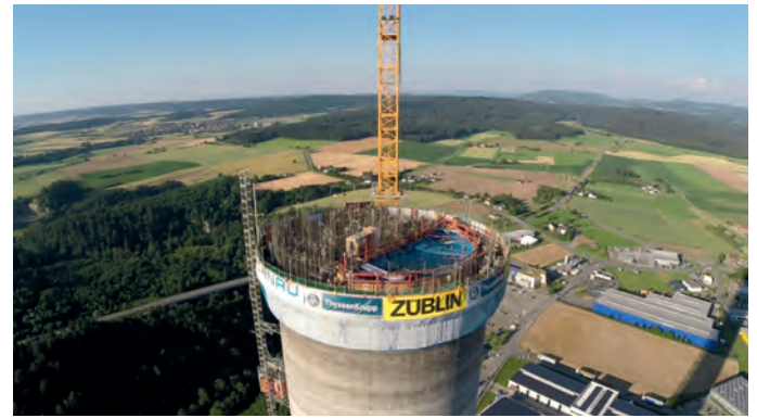
Abb. 3: Herstellung des Turmschaftes in Gleitbauweise
