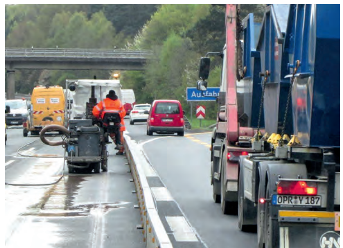
Abb. 5: Mitarbeiter beim Schneiden der Asphaltdecke mit Arbeitssitz der Trennschneidemaschine unmittelbar im Bereich der mobilen Schutzwand neben fließendem Verkehr
