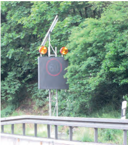
Abb. 2: Wechselverkehrszeichen zur Geschwindigkeitsreduzierung, dadurch konnten die zulässigen Geschwindigkeiten, je nach Arbeitseinsatz auf der Baustelle, verändert werden – keine klassische Beschilderung mit Zusatzzeichen
