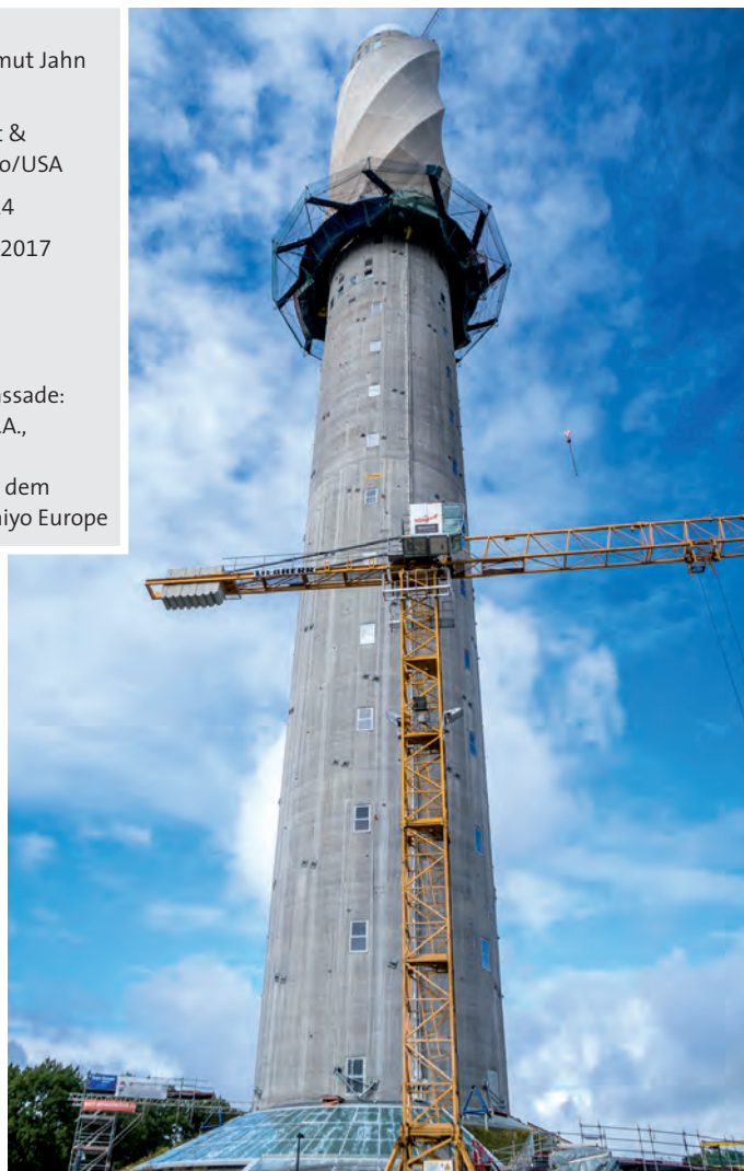
Abb. 1: Ein Bau der Superlative ist der Aufzugstestturm der thyssenkrupp Elevator AG in Rottweil, der sich mit 246 m Höhe über alle Gebäude Baden-Württembergs erhebt
