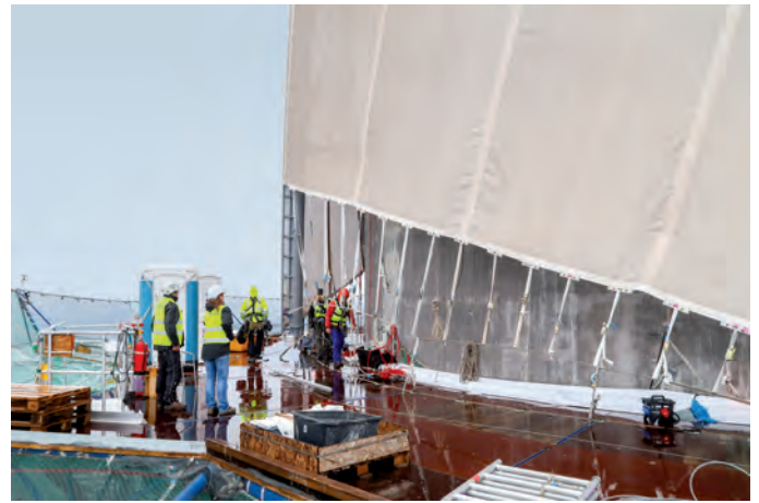
Abb. 2 und 3: Am thyssenkrupp-Testturm in Rottweil verbindet eine Stahlkonstruktion die Außenmembran mit den Betonwänden. Diese Konstruktion verankern die Fassadenbauer mit Schwerlastbefestigungen von fischer fest am Verankerungsgrund
