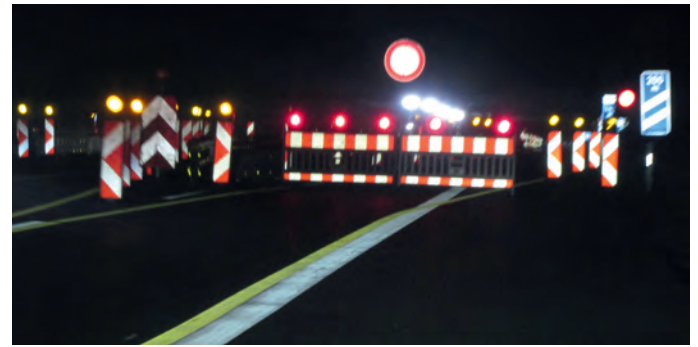
Abb. 6 und 7: Fahrtrichtung in Richtung Butzbach ab der Anschlussstelle Bergwerkswald gesperrt, weil keine ausreichenden Sicherheitsabstände zwischen Verkehrs- und Arbeitsbereich zur Verfügung standen.
