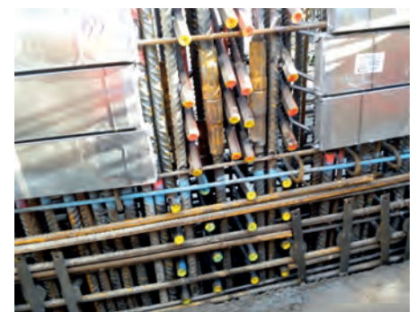
Abb. 6: Schraubanschlüsse zum Anschluss der Schottwände an den Turmschaft
