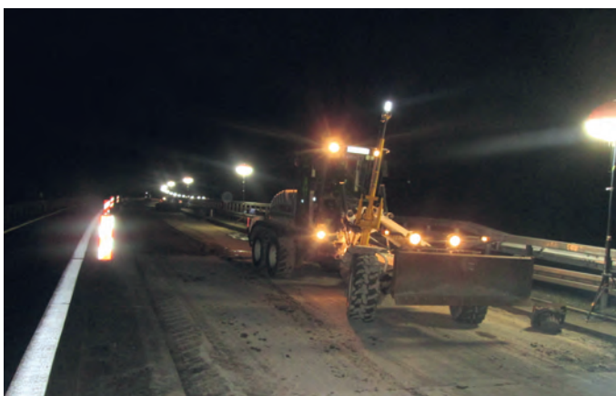
Abb. 9: „Grobe Tätigkeiten“ im Straßenbau mit 50 Lux beleuchtet
