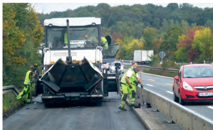
Abb. 1: Im Zuge der einzelnen Bauphasen stand kein ausreichender Arbeitsraum für die Mitarbeiter zur Verfügung
