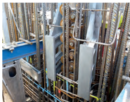
Abb. 5: Einbau von massiven Stahleinbauteilen in hochbewehrten Wandbereichen
