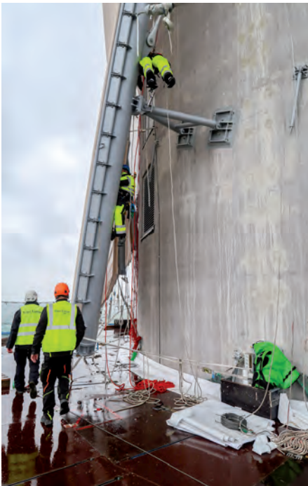
Abb. 2 und 3: Am thyssenkrupp-Testturm in Rottweil verbindet eine Stahlkonstruktion die Außenmembran mit den Betonwänden. Diese Konstruktion verankern die Fassadenbauer mit Schwerlastbefestigungen von fischer fest am Verankerungsgrund
