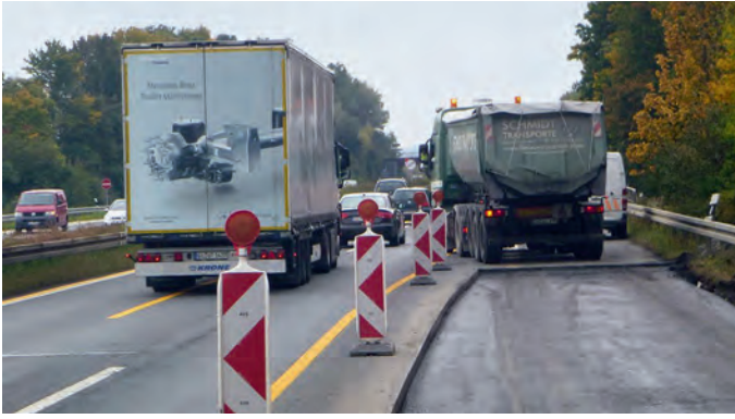
Abb. 11: Baustellenzu- und -ausfahrten bilden erhebliche Unfall- schwerpunkte – Leitbaken als Schutz- einrichtung zum fließenden Verkehr, um beladene Baustellen-Lkw aus dem Stand in den fließenden Verkehr einfädeln zu lassen
