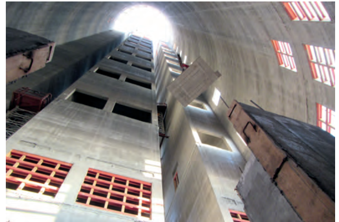
Abb. 4: „Einfliegen“ der Filigrandeckenelemente in das Turminnere
