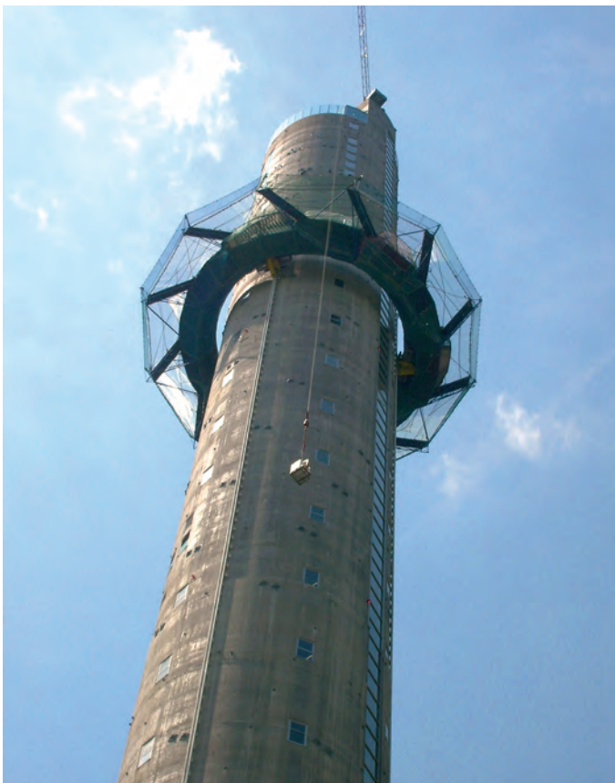
Abb. 9: Montageshuttle mit Triebstockschienen- antrieb im Einsatz
