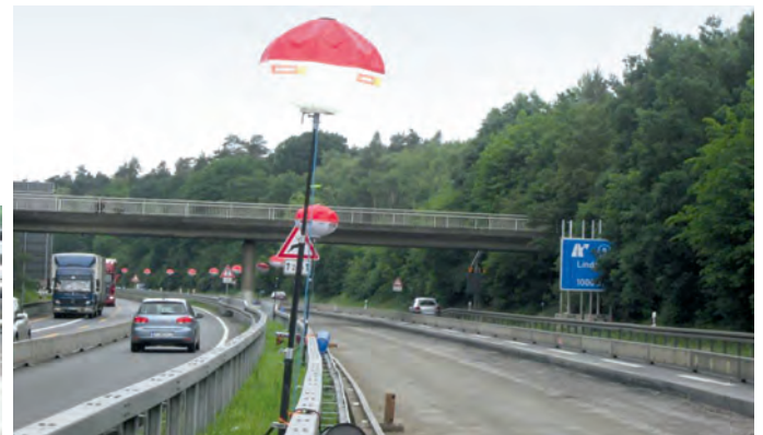
Abb. 8a, b: Beleuchtung durch Leuchtbälle (Powermoons, jeweils 30 m Abstand) betrieben von Stromaggregaten
