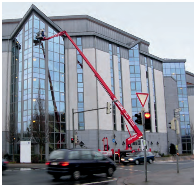
Abb. 3: Reinigen mit Hubarbeitsbühne
