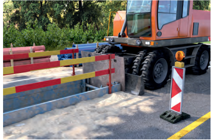
Abb. 10: Stirnseitiger Verbau mit Stahlplatte und Absturzsicherung während Arbeitspause
