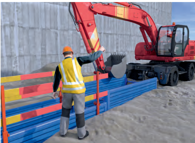
Abb. 13: Absturzsicherung am Vebau bei Baggararbeiten am Graben
