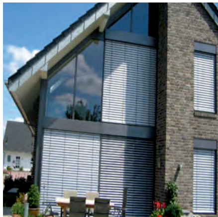
Abb. 1: Schwerer Unfall beim Reinigen des Dreiecksfensters
