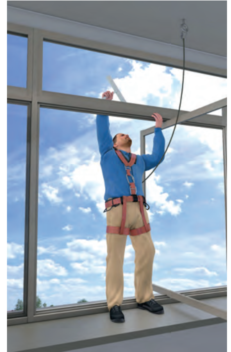
Abb. 10: Anseilsicherung mit Anschlagssystem
