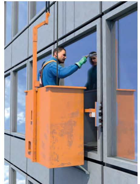
Abb. 7: Fassadenbefahranlage
