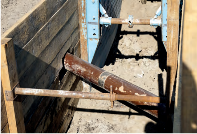
Abb. 9: Kreuzende Leitung, mit waagrechttem Verbau eingefasst
