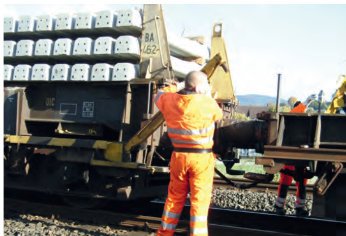
Abb. 3: Arbeitsplätze auf der Betriebsgleisseite der Materialwagen Slps (links) und MFS (rechts)
