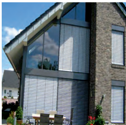
Abb. 1: Schwerer Unfall beim Reinigen des Dreiecksfensters
