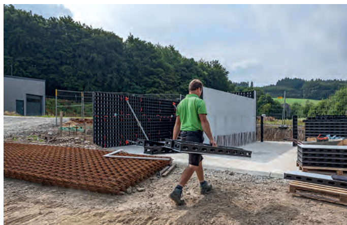
Abb. 1: Universale Verbundschalung DUO – Durch ihr leichtes Gewicht, ihre hammerfreie Montagetechnik und nahezu intuitiven Handhabung kann das Schalungssystem schnell, leise und sicher aufgebaut und bedient werden (Foto: PERI GmbH)
