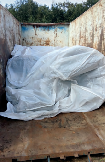
Abb. 3: In Big-Packs verpackte Asbestzementrohre vor Abtransport zur Entsorgung
