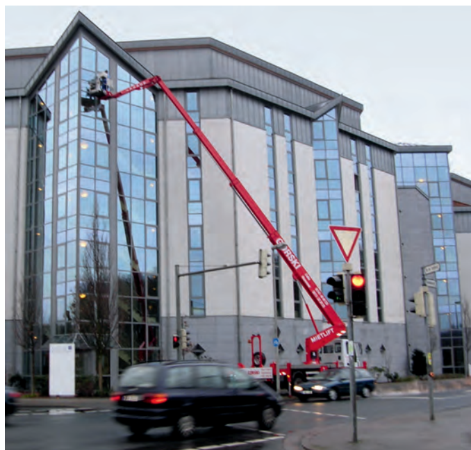
Abb. 3: Reinigen mit Hubarbeitsbühne
