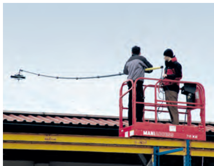
Mit Stangenreinigungssystemen können Photovoltaikanlagen sicher vom Boden oder von einem Hubsteiger aus gereinigt werden (Foto: Löwe)
