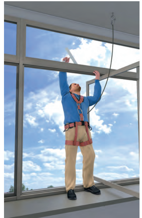
Abb. 10: Anseilsicherung mit Anschlagssystem
