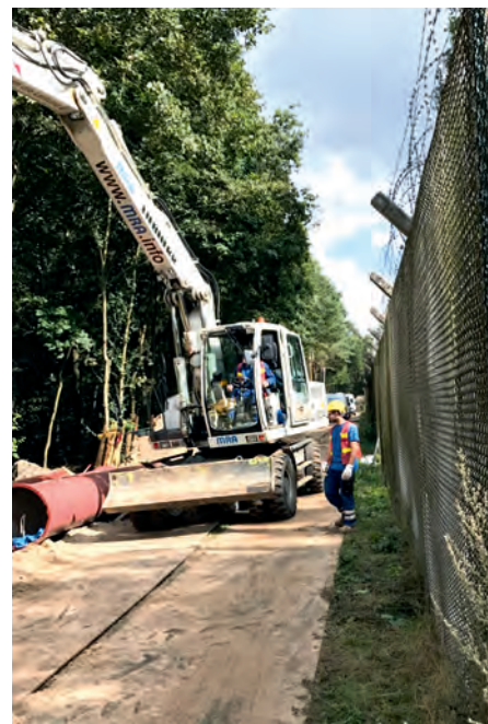
Abb. 2: Der Zaun auf der einen Seite der Baustelle und der Wald auf der anderen verlangten den Maschinenführern einiges an Fingerspitzengefühl beim Rangieren ab: Hier dürfen sich keine Personen im Gefahrenbereich aufhalten!
