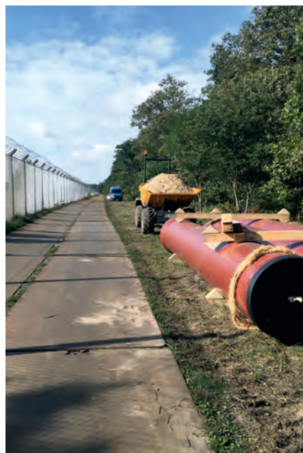
Abb. 1: Mit Stahlplatten ausgelegte Baustellenstraße entlang des Zauns am Flughafen
