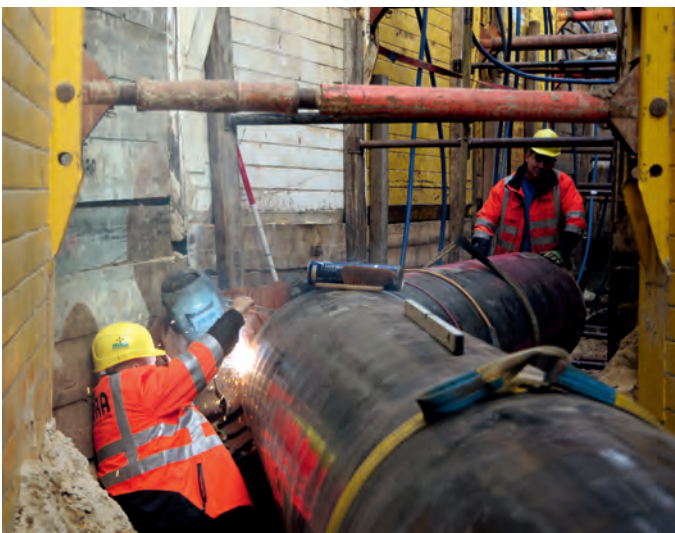
Abb. 4: Verschweißen der Stahlrohre innerhalb des Rohrgrabens bei einer Abwinkelung in der Leitungstrasse
