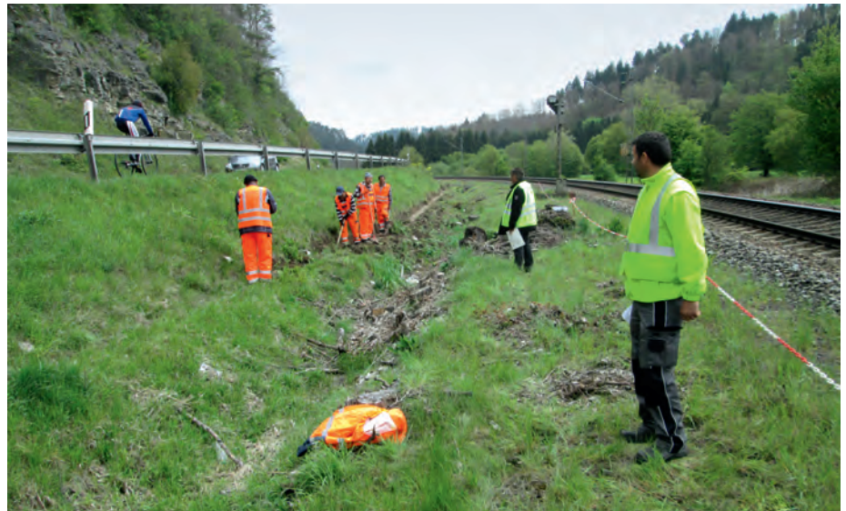
Abb. 4: Arbeitsbereich und Schutzstreifen außerhalb des Gleisbereichs; rot-weiße Kette auf der Grenze Arbeitsbereich/Schutzstreifen (Foto: BG BAU, Hauff)
