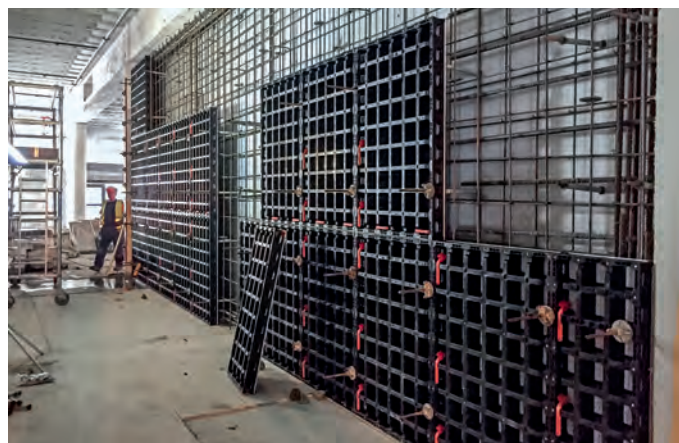
Abb. 2: Kleinformatige, leichte Schalungspaneele mit einfacher Handhabung und Montagelogik – ideal für das Schalen von Ort betonbauteilen bei beengten Platzverhältnissen oder erschwerten Baustellenzugängen (Foto: PERI GmbH)
