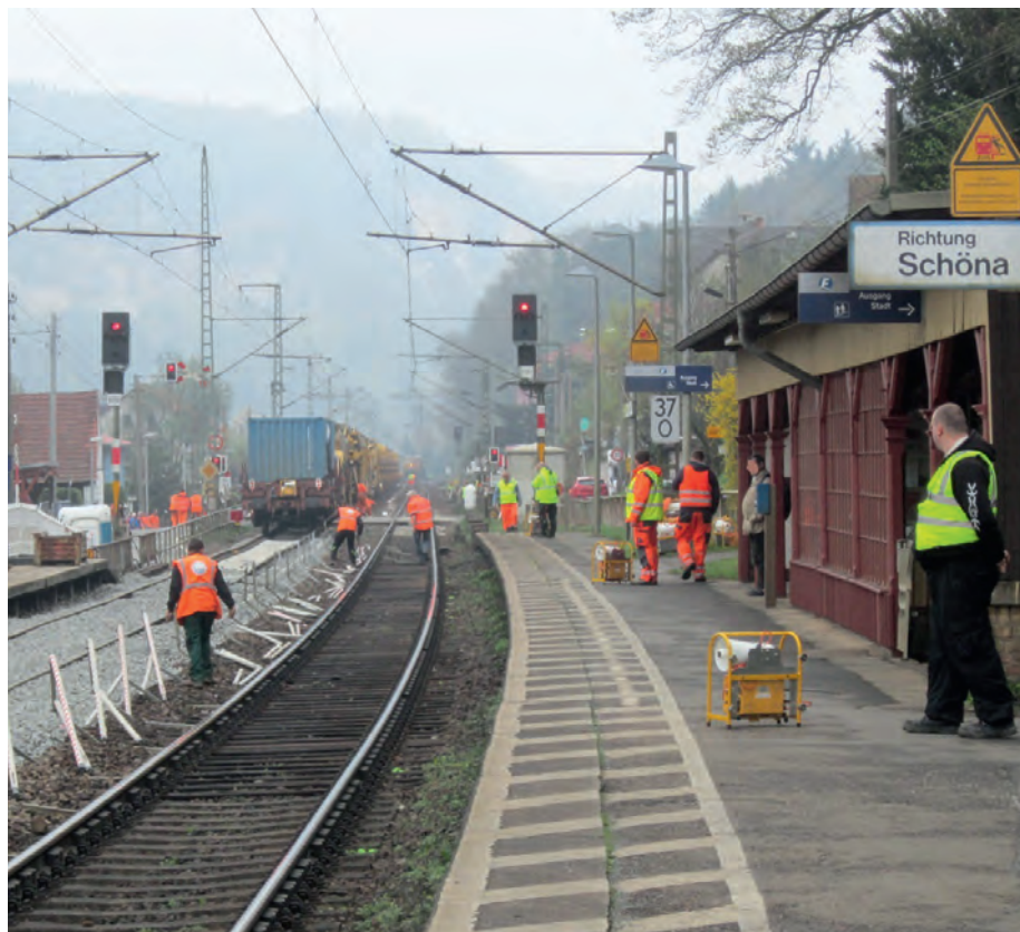
Abb. 8: Zur Sicherung der Lücke zwischen BRM (Maschinenwarnanlage) und FA werden funkgesteuerte Warnsignalgeber eingesetzt, mit denen die ÜP im Bedarfsfall Ro 3 geben können
