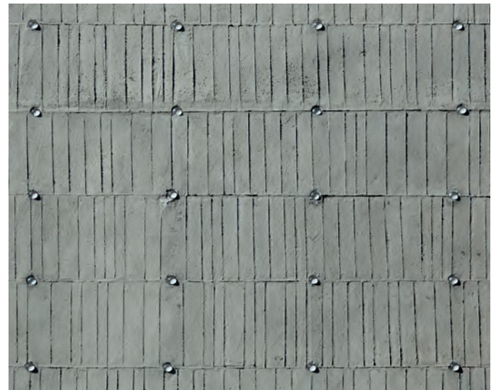
Abb. 8: Fassadendetail – Verklebte Pressglaslinsen (Foto: Heinrich Hermes)
