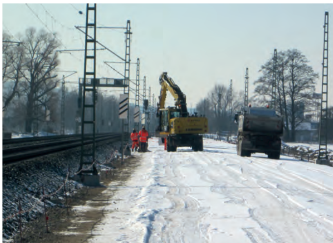
Abb. 2: Arbeiten neben einem Gleis – hier ist die Festlegung der Arbeitsbreite notwendig (Foto: BG BAU, Hauff)
