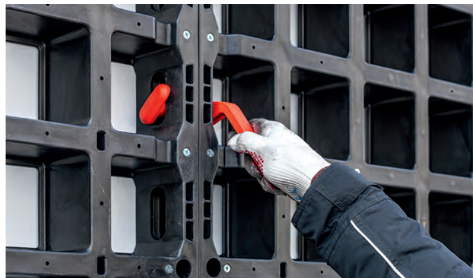
Abb. 4: Ein besonders gutes Beispiel für einfach bedienbare Systembauteile ist der DUO Verbinder. Sein Design und die dazu passende Form der Öffnungen in den Paneelen erlauben nur eine einzige Möglichkeit des Einbaus (Foto: PERI GmbH)
