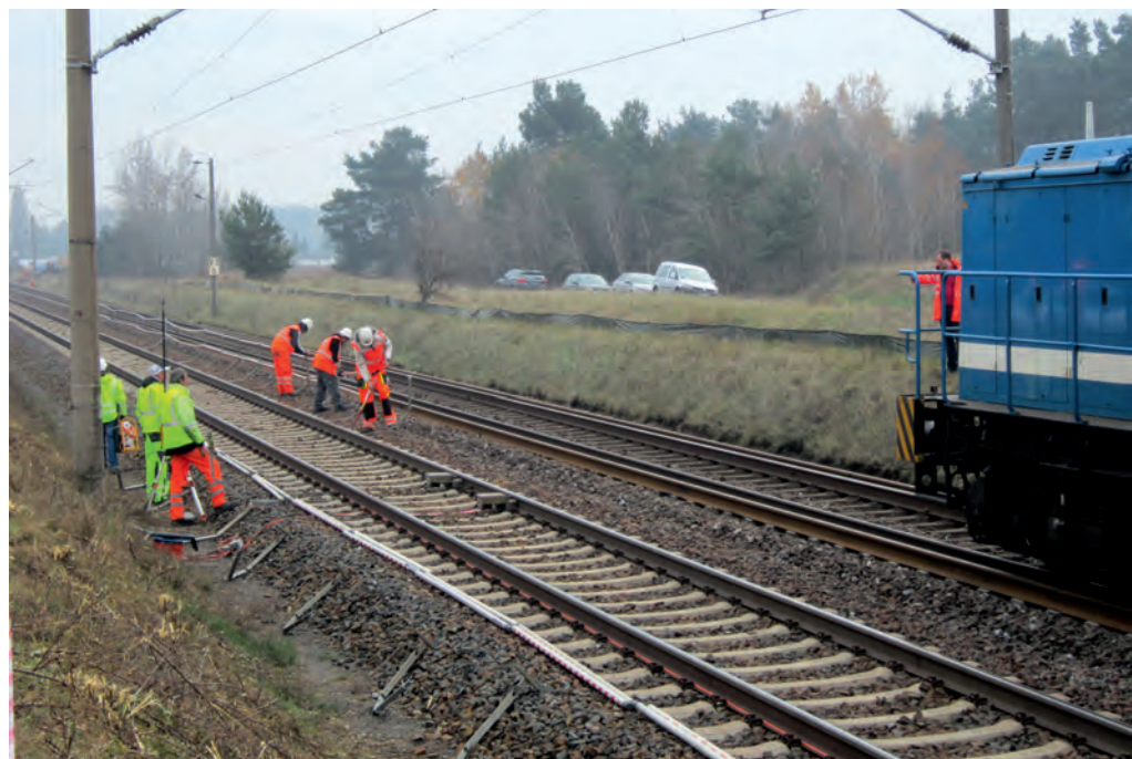
Abb. 1: Beim Verfahren FATWS wird die Feste Absperrung vor Arbeitszuglok bzw. Materialwagen der Fließbandmaschinen ab- und dahinter wieder aufgebaut
