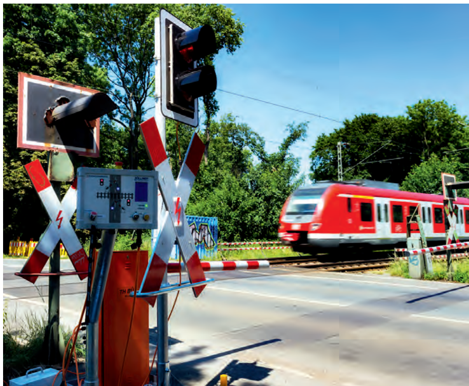
Abb. 1: Technisches Hilfsmittel Bahnübergangsposten TH-BÜP (Quelle: Fa. SDL)
