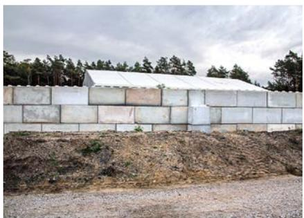
Splitterschutzvorrichtungen und Erdwälle, um mögliche Detonationen zu dämpfen
