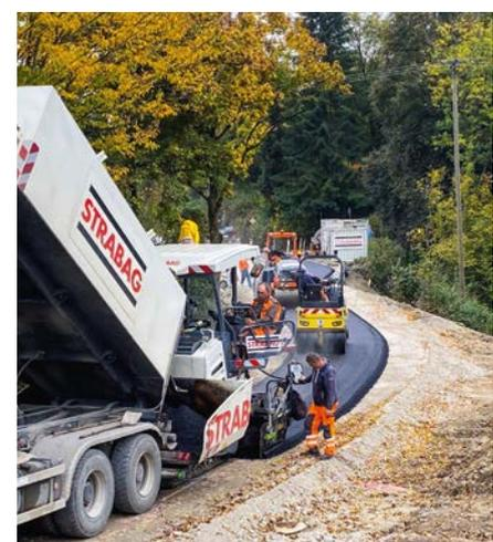
Biobitumen im Einsatz beim Bau eines Radwegs in Wildpoltweiler
