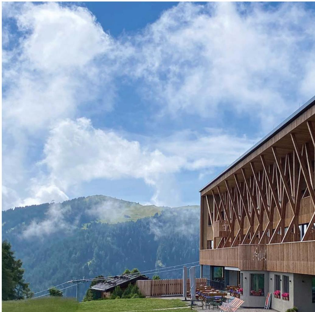
13 ineinandergreifende Holzstützen bilden die Kolonnade. Die gekreuzten Stämme sind aufgeschichtet und zu Verstrebungen verbunden. Sie tragen das zu Flügeln geformte neue Dach.
