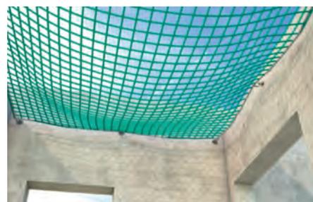
Abb. 2: Kleinformatisches Schutznetz ca. 3 m x 3 m in einem Holzrahmen (Foto: BG BAU – T.-P. Glaser)
