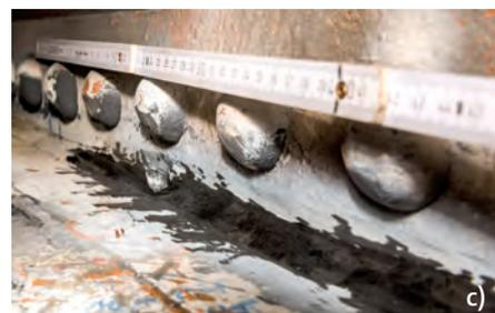
Abb. 5a–c: a) Detailaufnahme des Risses in der Versteifung der Brücke (30.11.2012) – b) + c) Ein 400 mm langer Riss wurde in einer Seil-traverse im Sommer 2016 festgestellt und repariert
