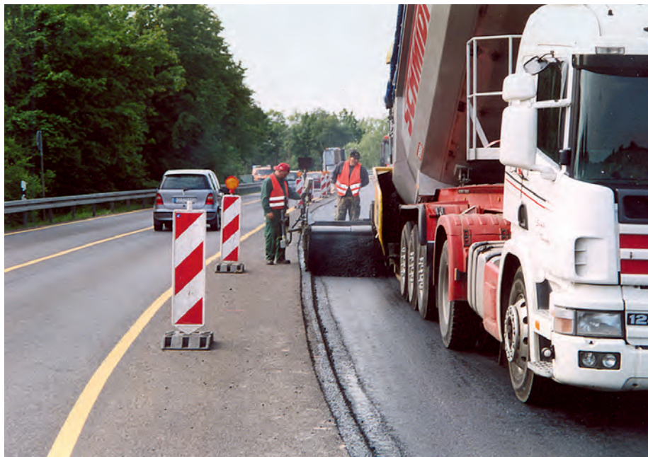
Abb. 4: Absicherung durch Baken bei ausreichender freier Bewegungsfläche für den Beschäftigten und ausreichendem Sicherheitsabstand zum vorbeifließenden Verkehr
