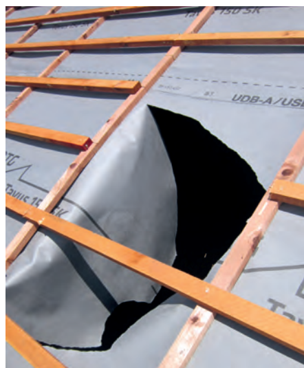
Abb. 1 + 2: Unsachgemäße und fehlende Befestigung von Dachlatten führte zu einem Absturzunfall (Fotos: A. Potthoff, BG BAU)
