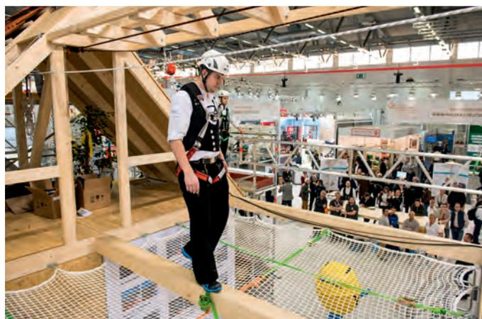
Abb. 5: Lifeline mit einer Spannweite bis zu 12 m (Foto: Matzke)
