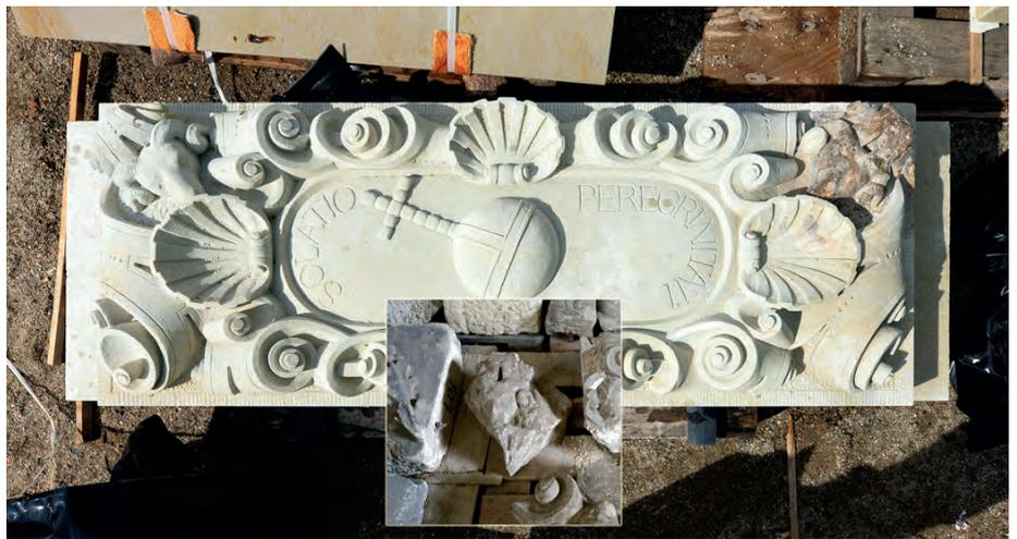
Abb. 7: Historische Fundstücke, z.B. Sandstein-Bruchstücke, wurden in den Neubau integriert
