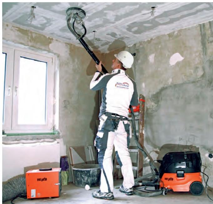
Luftreiniger bestehen vereinfacht ausgedrückt aus einem Ventilator und Filter(n) sowie Ansaug- und Abluftöffnungen mit Ansaug- oder Abluftschlauch. Wie bei den Bau-Entstaubern wurden auch für Luftreiniger von der BG BAU mit den Herstellern Anforderungen festgelegt, die eine hohe Praxistauglichkeit auf Baustellen gewährleisten. Der Anwendungsbereich ist auf den Luftreinigern verzeichnet. Dort ist die maximal empfohlene Raumgröße in Quadratmetern angegeben.
