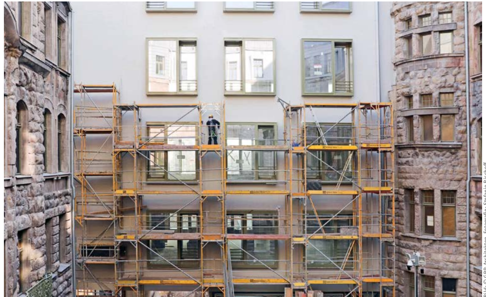
Sicheres Arbeiten im Gerüst
