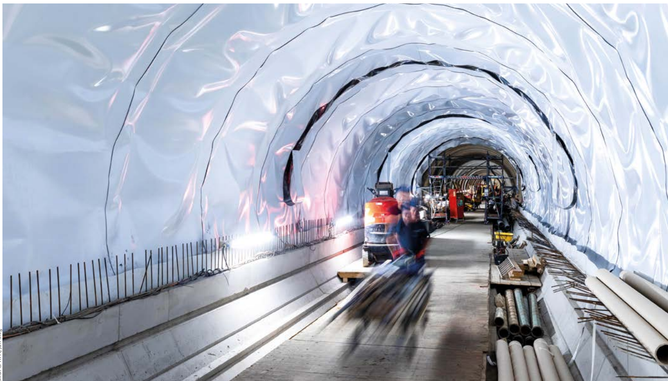
Einbau einer Flächendränage und einer Abdichtung oberhalb des Sockelbereichs
