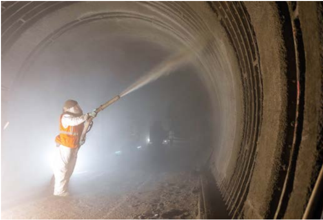
Spritzbetonarbeiten in der Betoninnenschale
