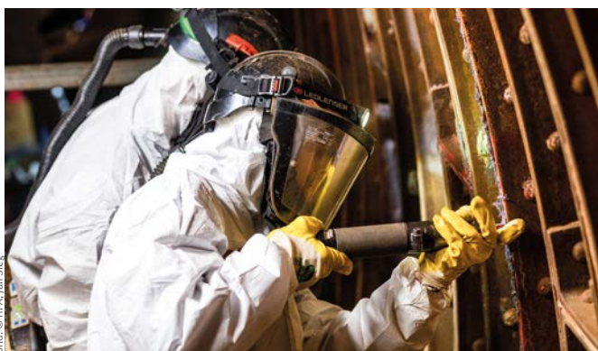
Verstemmen der Bleifugen unter Vollschutz
