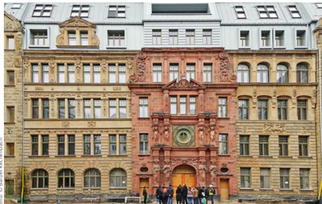
Ingenieure und Studenten besichtigen, organisiert von der Baukammer Berlin, die Baustelle im Innenhof.
