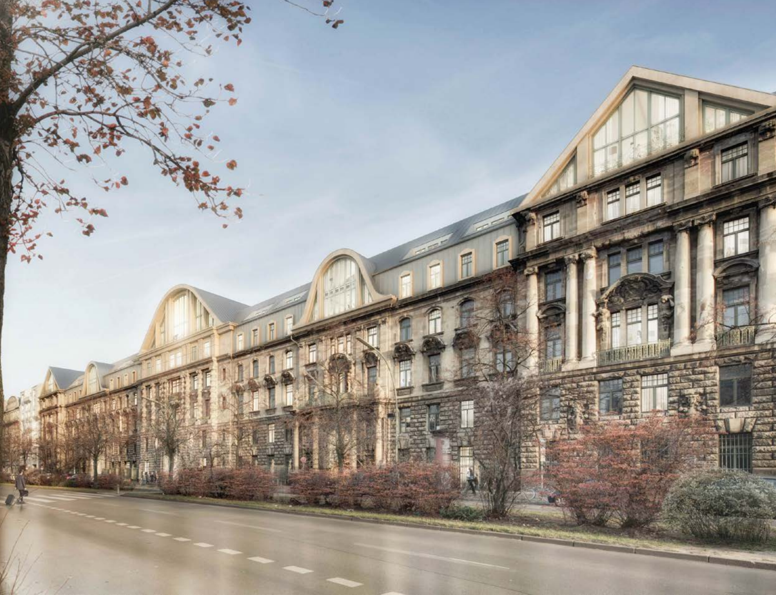
Visualisierung der restaurierten Fassade des Hauptgebäudes mit neuer Dachkuppel nach Fertigstellung
