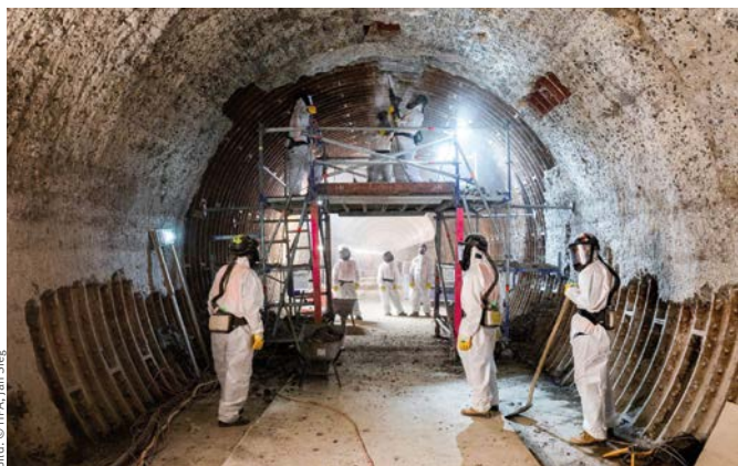
Handabbruch im Gewölbe
