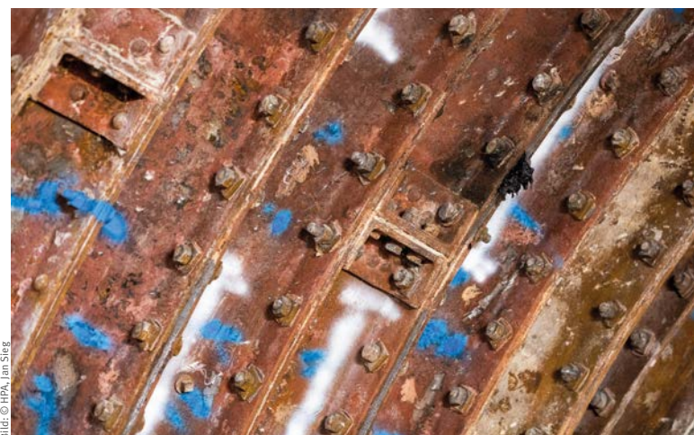
Nahaufnahme der zu sanierenden Tübbings
