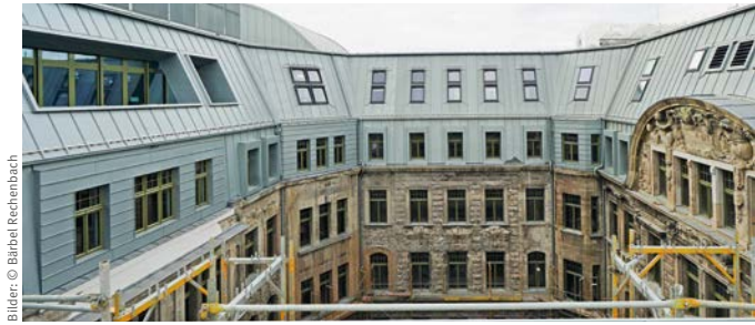
Aufstockung mit einem fünften Obergeschoss und Dachterrasse
