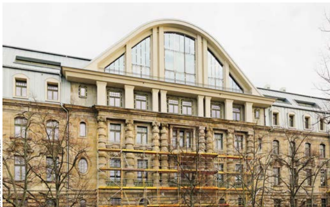
Teil der Sanierung ist die Restaurierung der Fassade.
