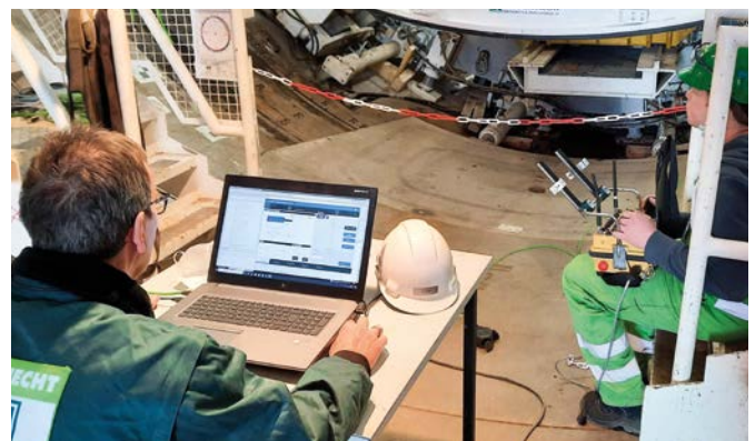
Abb. 3: Test automatischer Ringmontagesysteme in Schwanau: Vakuumsaugplatte eines Feldprototyps für die automatische Ringmontage an einem 3-m-EPB-Schild (links) und Versuchsanordnung einer 8-m-TBM (rechts)
