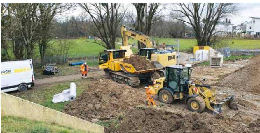
Die Maßnahmen zur Bodenaufbereitung am Wasserwerk in Förch stellen sicher, dass der Aushub für den Wiedereinbau verwendet werden kann.
