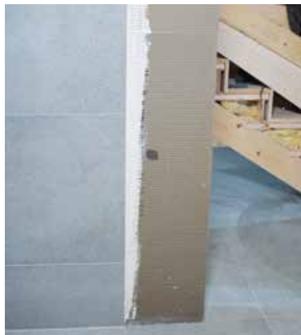
Unter den grauen Fliesen in den Sanitäranlagen sowie im Eingangsbereich wurden die „BP Bauplatten“ verbaut. Als Untergrund für den Fliesenbelag wurde Leichtfliesenkleber verwendet.
