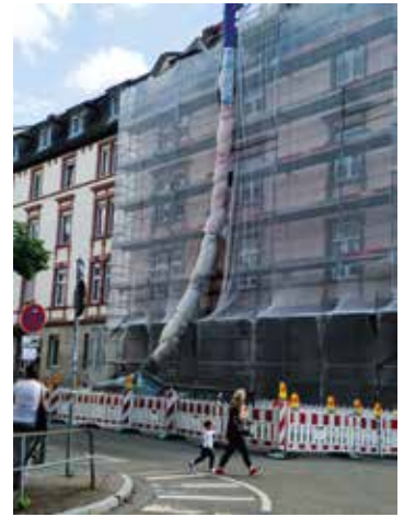
Eingehauste Schüttrutschen verringern die Staubbelastung.
