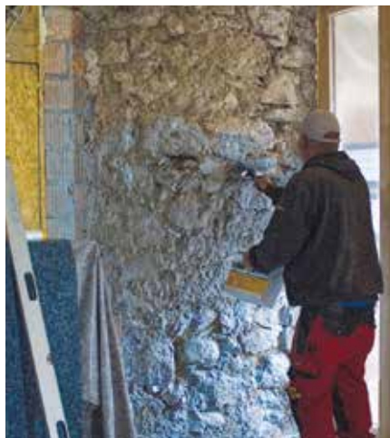
Die Steinwand des Bestands wurde mit der Grundierung „D1 Speed“ für die spätere Aufnahme des Putzes vorbehandelt.
