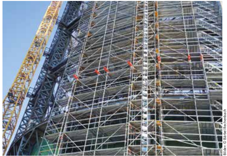
Gerüst und Einhausung „wandern“ abschnittsweise um das Bauwerk mit.
