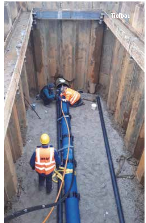
Um eine geschützte Weide und einen Bach auf 40 m schonend zu unterqueren, führte REIF auch eine Horizontaldurchpressung mit Stahlrohren DN 600 durch. Hierin werden die Wasserleitung DN 300 sowie Leerrohre für den Breitbandausbau eingezogen.
