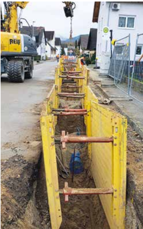
Ein Großteil der neuen Trinkwasser-Transportleitung wird in konventioneller Bauweise hergestellt. Verlegt werden GGG-ZM-Rohre der Nennweite DN 300.
