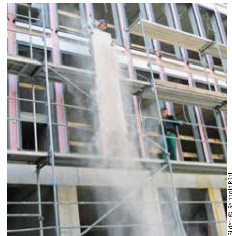
Staubbelastung beim Gerüstbau
