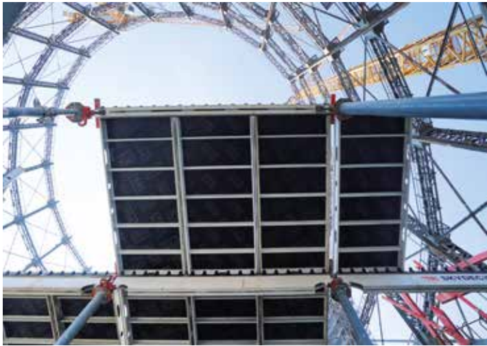
Das neue Bürohaus wächst geschossweise.
