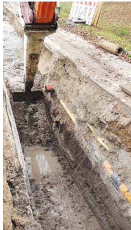
Wegen des anstehenden Grundwassers erfolgte auf 480 m die Grabenverfüllung mit Flüssigboden.
