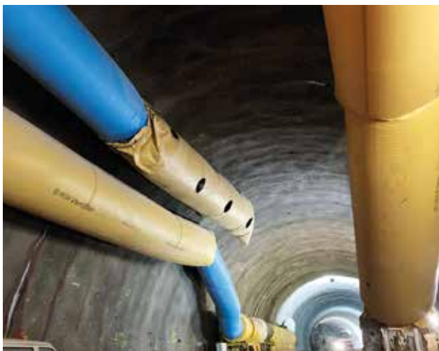
Bild: © ARGE Tunnel Brandberg
