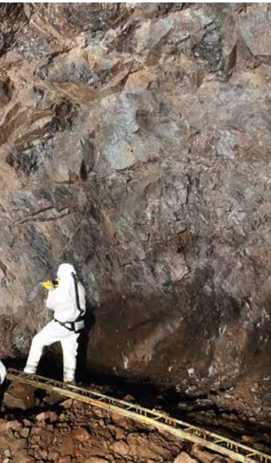
Bild: © ARGE Tunnel Brandberg
