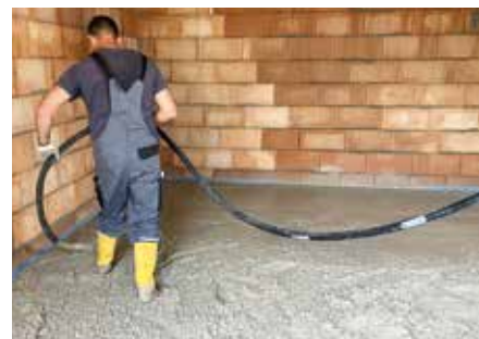
Mit „alcemy“ hergestellter „Low Carbon Concrete“ für die Bodenplatte einer Garage in Anröchte: w/z-Wert 0,35 bei nur 84 kg CO 2 pro Kubikmeter Beton
