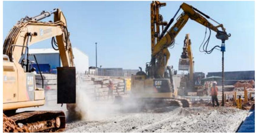
Fräsen der Betondecke des Wellensturbeckens in 1,5 m × 1,5 m große Quadrate sowie Abteufen der Bohrungen für die 4-REM-Sonde
