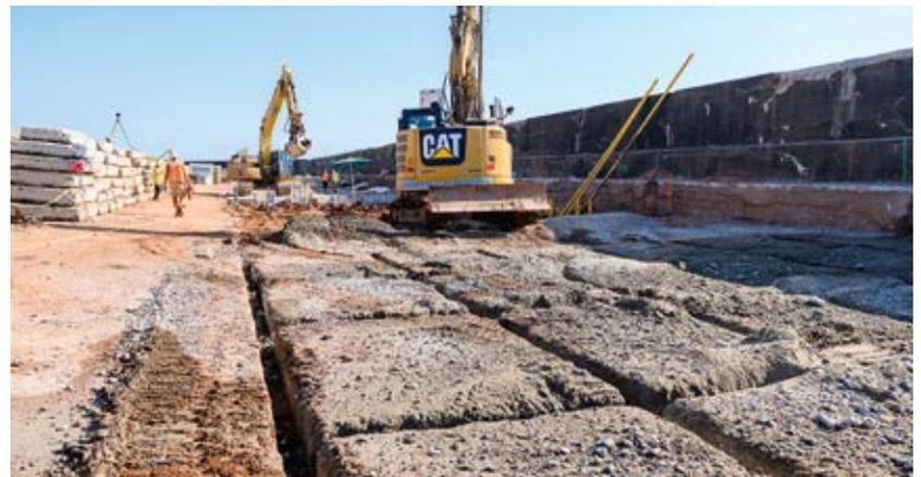
Betondecke mit den Quadraten nach dem Fräsen
