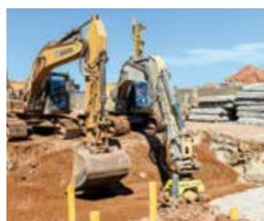
Lagenweiser Bodeneinbau und Verdichtung auf engstem Raum
