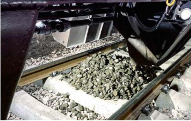
Der entladene Schotter ist sichtbar befeuchtet.
