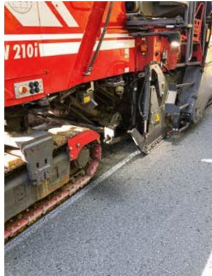
Abb. 1: Markierung der Fräslinie auf der verkehrsabgewandten Seite
