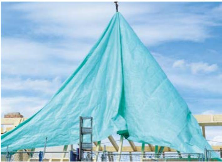
Wetterbedingt mussten immer wieder Schutz-Folien zur Abdichtung auf das geöffnete Dach aufgebracht werden.
