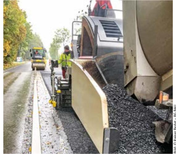
Abb. 8: Verdichtungsarbeiten im fließenden Straßenverkehr
